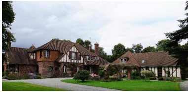
Élévations antérieures. Phot. Marie-Laure Monnehay-Vulliet IVR22_20128001071NUC2A
