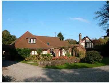
Dépendances et arcades précédant le logis. Phot. Frédéric Fournis IVR22_20118001575NUCA
