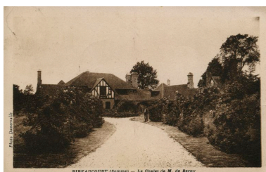
Vue générale depuis le portail d'entrée, années 1930 (coll. part.) Phot. Monnehay-Vulliet Marie-Laure IVR22_20118000154NUCA
