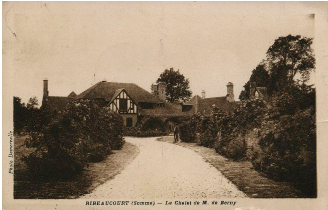
Vue générale depuis le portail d'entrée, années 1930 (coll. part.).
