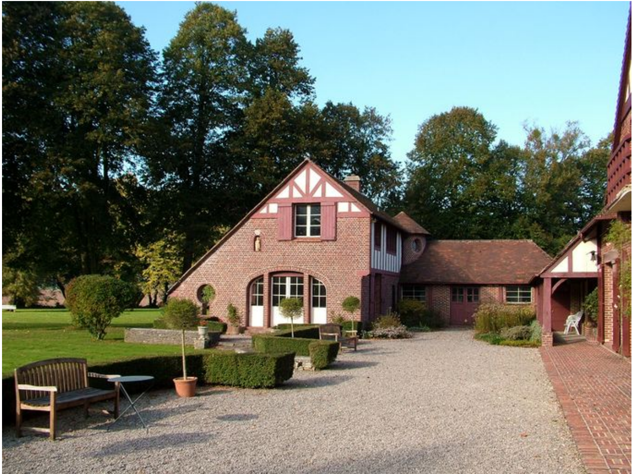
Bâtiment en retour d'équerre et pavillon postérieur.
