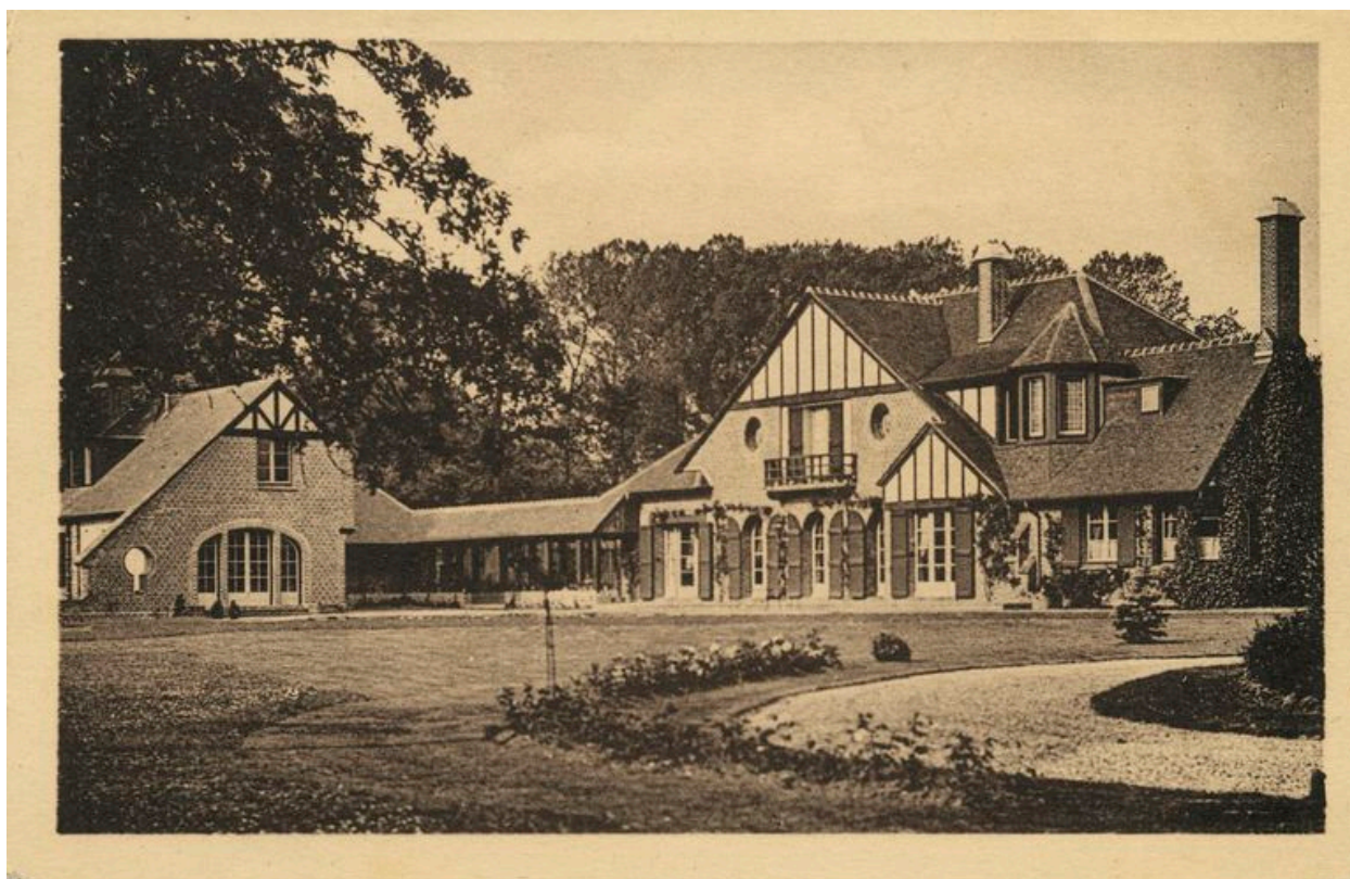
Vue générale depuis l'arrière, avant 1936 (coll. part.).
