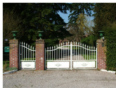
Portail principal ouvrant sur la rue de l'Église. Phot. Frédéric Fournis IVR22_20118001095NUCA
