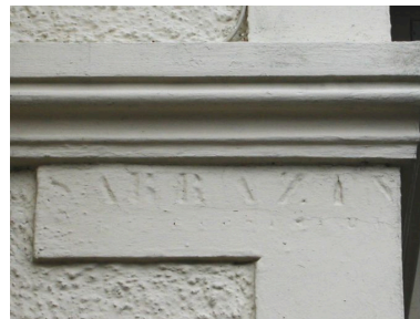
Détail de l'inscription 'Sarrazin' gravée en creux sur le nu du mur. Phot. Elisabeth Justome IVR22_20058002788NUCA
