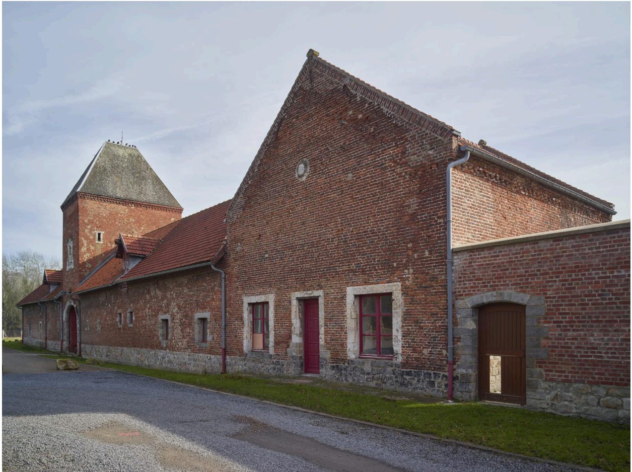
Vue générale de la façade donnant sur rue, prise depuis le sud-ouest.
