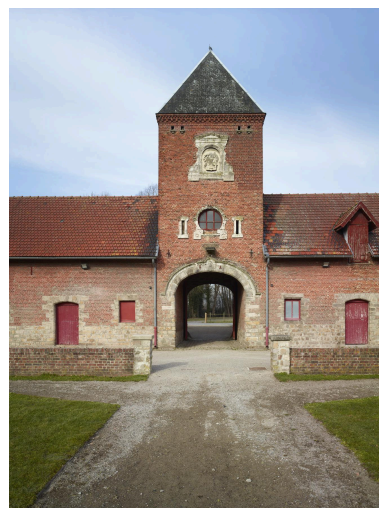
Détail de la tour porche depuis la cour intérieure Phot. Pierre Thibaut IVR32_20236200065NUCA
