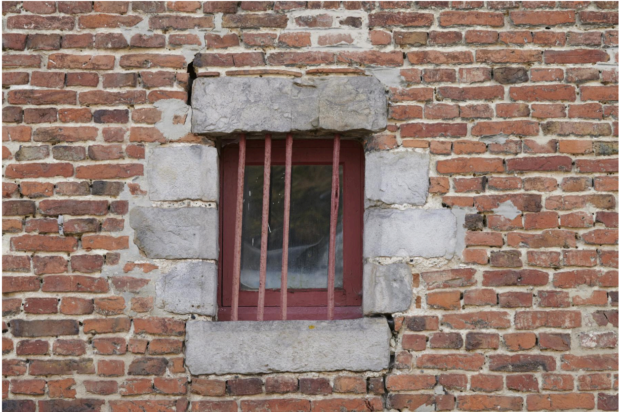
Détail de l'encadrement en grès d'une des ouvertures.
