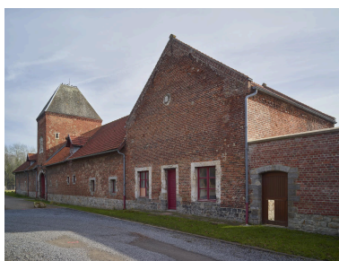
Vue générale de la façade donnant sur rue, prise depuis le sud-ouest. Phot. Pierre Thibaut IVR32_20236200080NUCA
