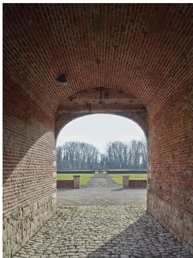
Passage charretier. Vue prise vers la cour intérieure. Poutre contenant le chronographe "1725". Phot. Pierre Thibaut IVR32_20236200078NUCA
