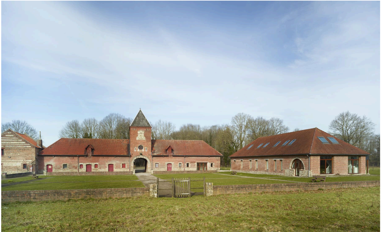
Vue générale des bâtiments depuis la cour intérieure.
