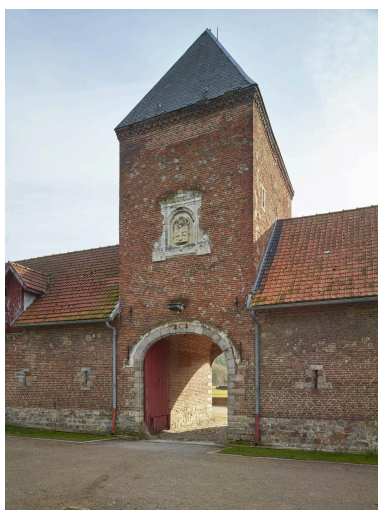
Tour porche. Vue prise depuis la rue. Phot. Pierre Thibaut IVR32_20236200081NUCA
