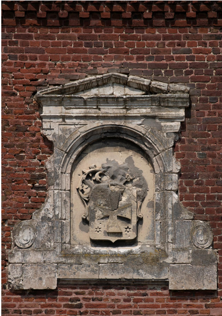
Tour porche (côté cour interne). Détail du cartouche architecturé de la tour-porche.
