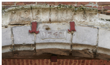
Détail du chronographe "1740" présent sur la clé de voûte de l'entrée charretière, côté extérieur de la tour porche. Phot. Pierre Thibaut IVR32_20236200056NUCA
