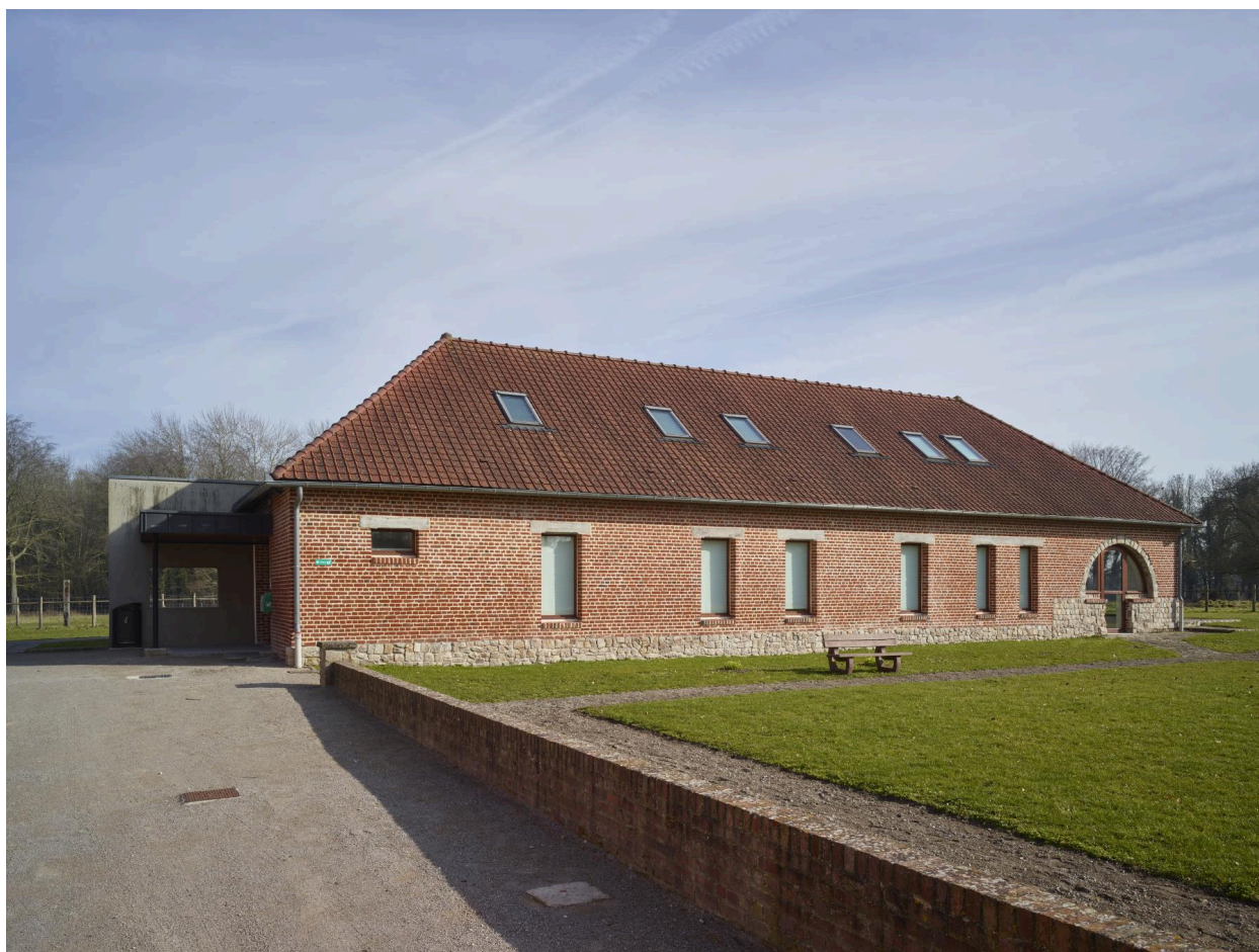
Vue générale du nouveau bâtiment, prise depuis la cour intérieure.
