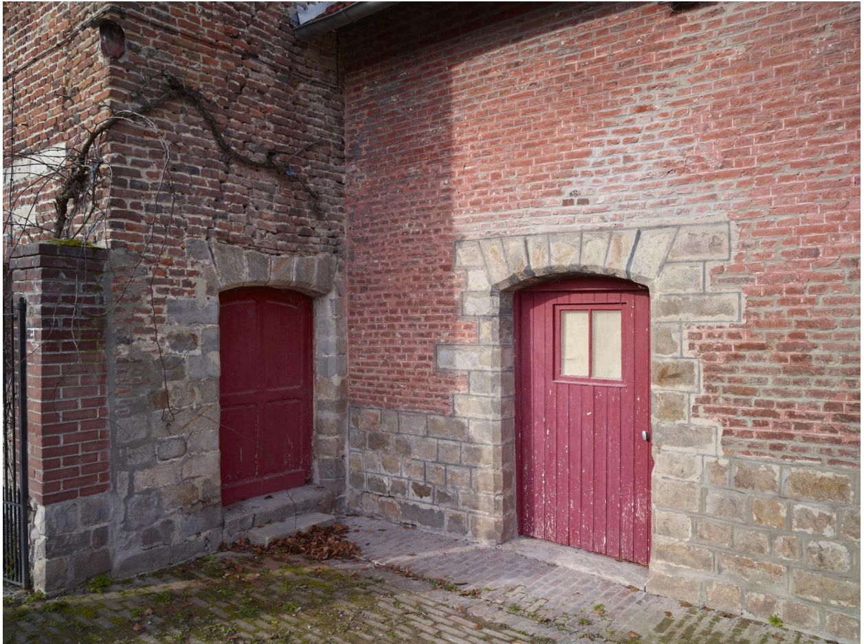
Détail des portes à l'angle du bâtiment sud-ouest et du bâtiment agricole adjacent. Vue depuis la cour intérieure.
