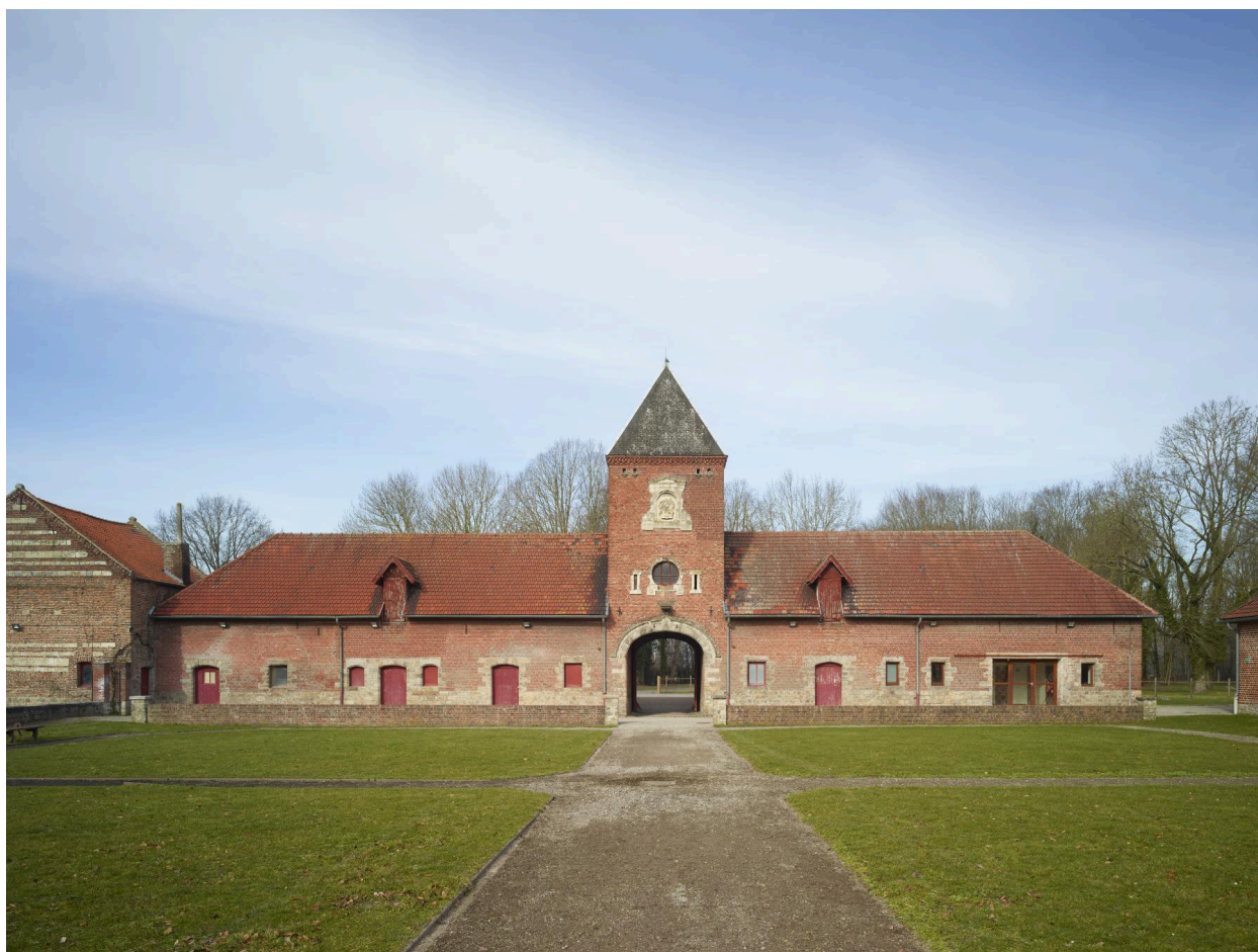
Vue générale des bâtiments depuis la cour intérieure.
