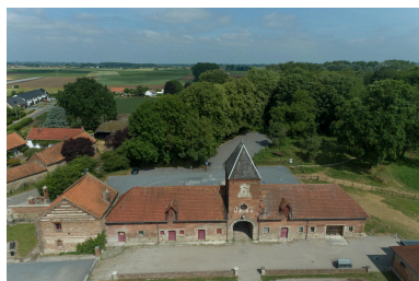
Vue aérienne de la façade côté cour. Phot. Marc Kérignard IVR32_20236200586NUCA
