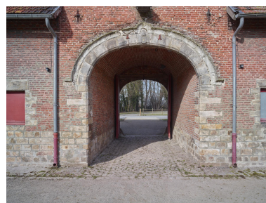
Passage charretier sous la tour porche. Vue prise depuis la cour intérieure. Blason de Jean Sarrazin en clé de voûte. Phot. Pierre Thibaut IVR32_20236200073NUCA
