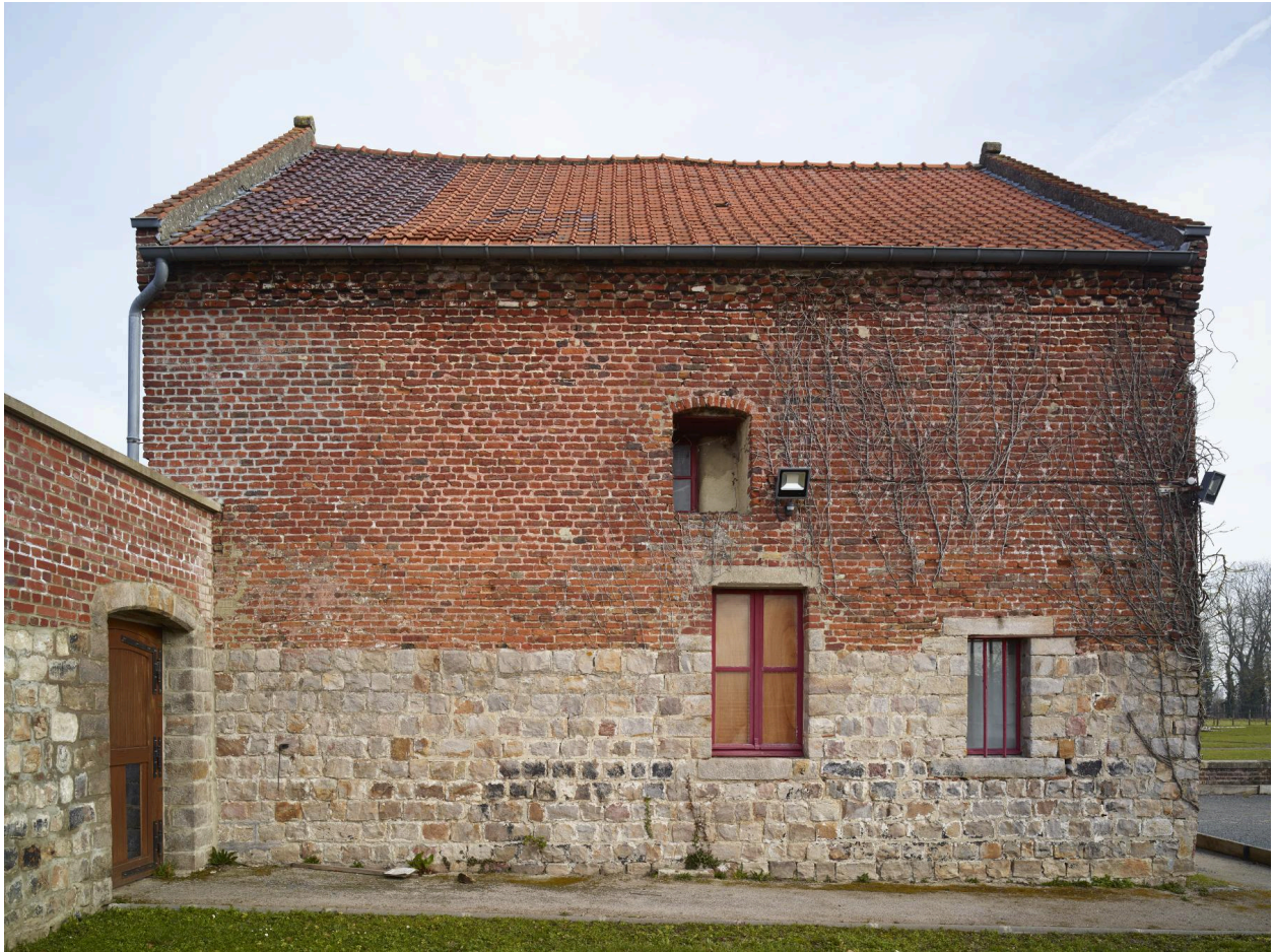
Bâtiment sud-ouest. Vue du mur gouttereau donnant sur la cour intérieure.
