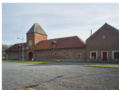
Vue générale de la façade depuis la rue. Phot. Pierre Thibaut IVR32_20236200082NUCA
