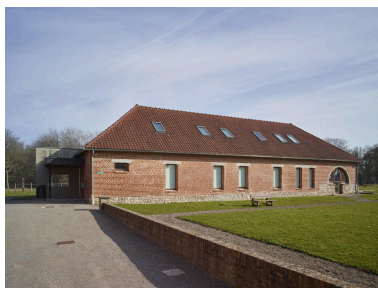
Vue générale du nouveau bâtiment, prise depuis la cour intérieure. Phot. Pierre Thibaut IVR32_20236200083NUCA
