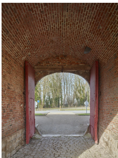
Passage charretier sous la tour porche. Vue prise vers la rue. Phot. Pierre Thibaut
