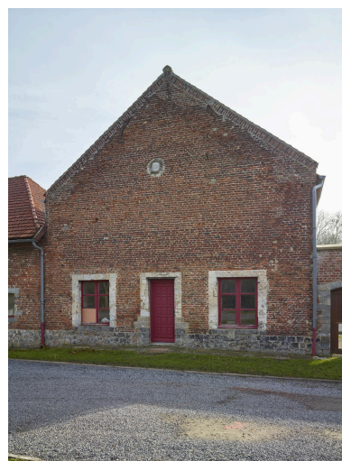
Mur-pignon du bâtiment sud- ouest. Vue prise depuis la rue. Phot. Pierre Thibaut IVR32_20236200079NUCA
