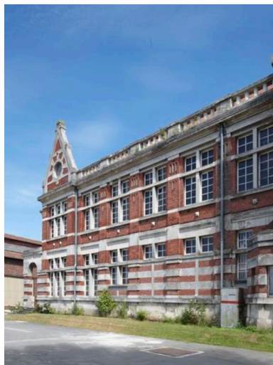
Vue partielle des bureaux, élévation antérieure. Phot. Hubert Bouvet IVR31_20105900356NUCA
