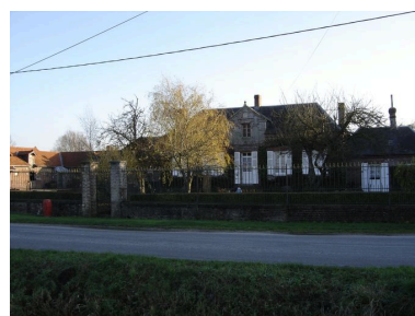
Vue d'ensemble de la façade du logis. Phot. Catherine Fourmond IVR22_20048001051NUCA
