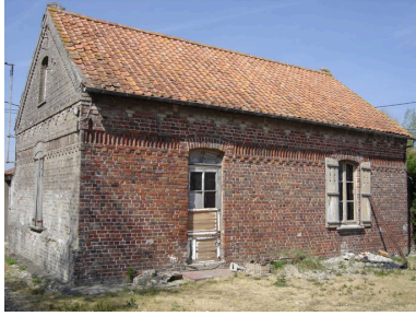
Vue du logement annexe depuis la cour. Phot. Inès Guérin IVR22_20078005962NUCA
