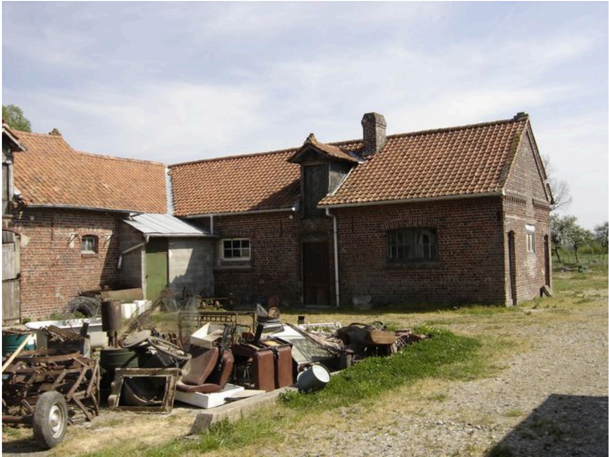
Vue des étables au sud-est de cour.
