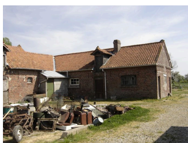
Vue des étables au sud-est de cour. Phot. Inès Guérin IVR22_20078005959NUCA
