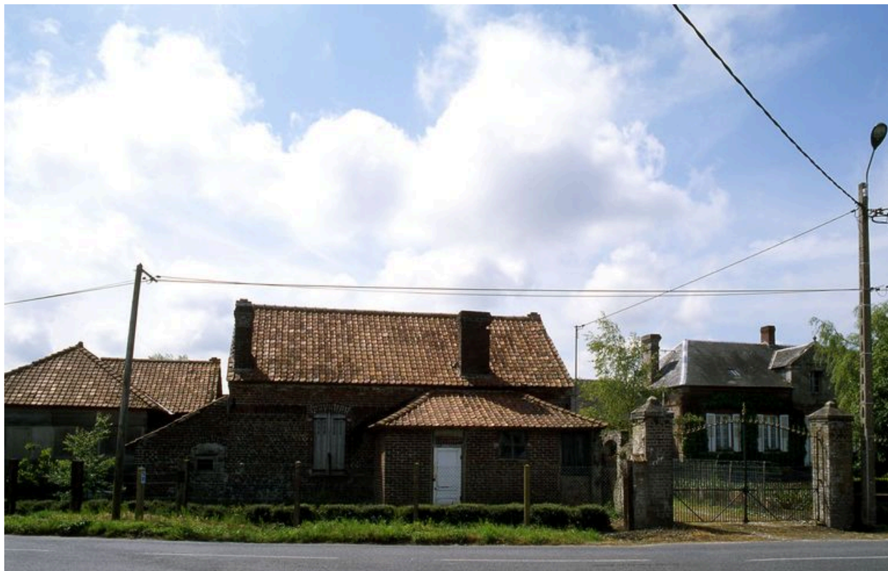
Vue du logement annexe au nord-est de la cour depuis la rue.
