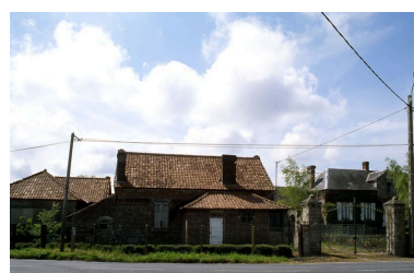
Vue du logement annexe au nord-est de la cour depuis la rue. Phot. Marie-Laure Monnehay-Vulliet IVR22_20058001137XA
