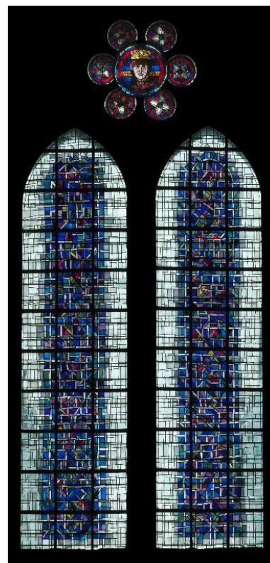
Vue générale de la verrière de la baie 108. Phot. Thierry Lefébure IVR22_20130200012NUC2AQ
