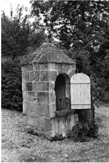
Vue générale du puits. Phot. Thierry Lefébure IVR22_19900201621X
