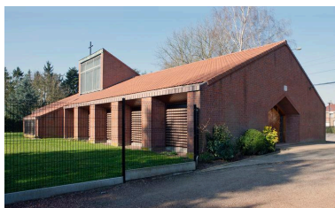
Élévation antérieure et flanc sud. Phot. Pierre Thibaut IVR31_20145903194NUCA
