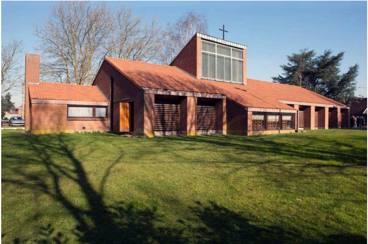
Flanc sud de l'église.
