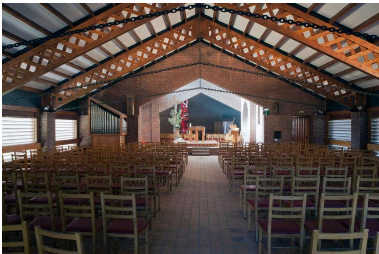
Vue générale du chœur depuis la partie antérieure de l'église.
