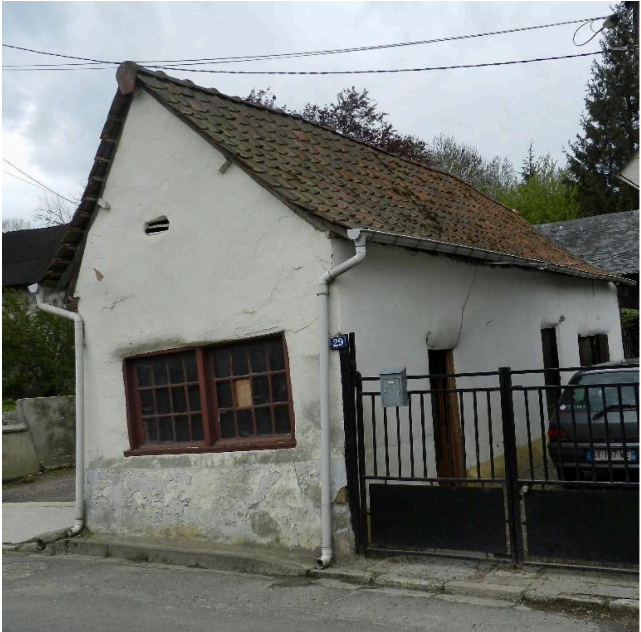
Atelier de serrurerie, rue de Bas.
