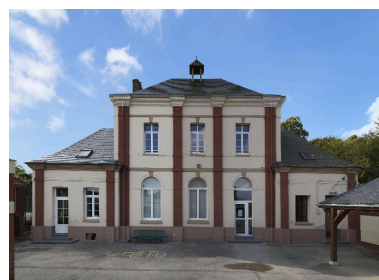
L'école et la mairie de Vaudricourt. Phot. Thierry Lefebure IVR22_20158000779NUC2A
