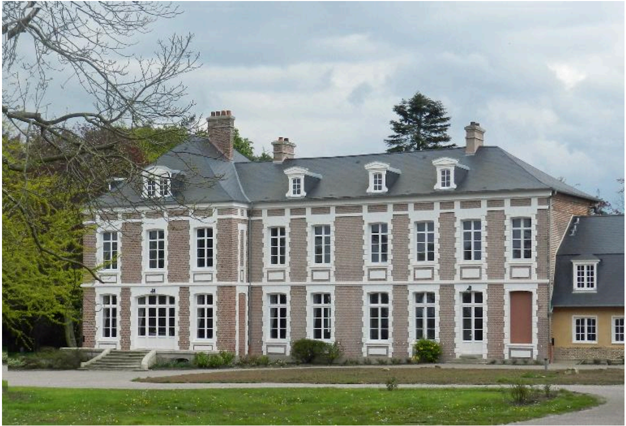
Le château, rue de Poireauville.
