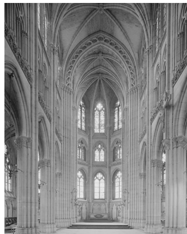
Vue intérieure vers le chœur. Phot. Michaël Troivaux IVR22_19968000308V
