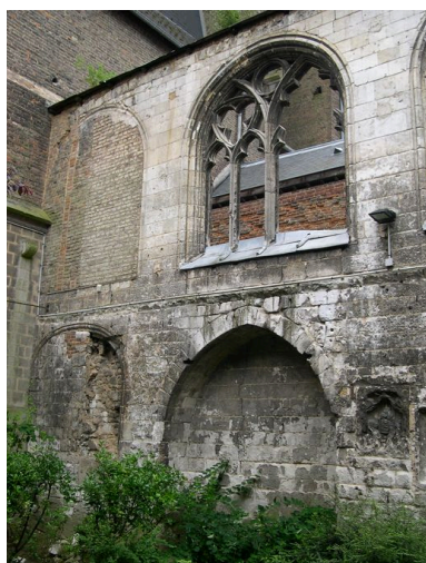
Vestiges de l'ancienne église conventuelle, vue intérieure baie du mur sud. Phot. Isabelle Barbedor IVR22_20048010826NUCA
