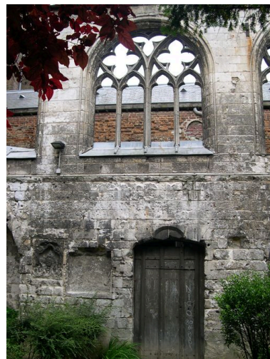
Vestiges de l'ancienne église conventuelle, vue intérieure baie du mur sud. Phot. Isabelle Barbedor IVR22_20048010827NUCA
