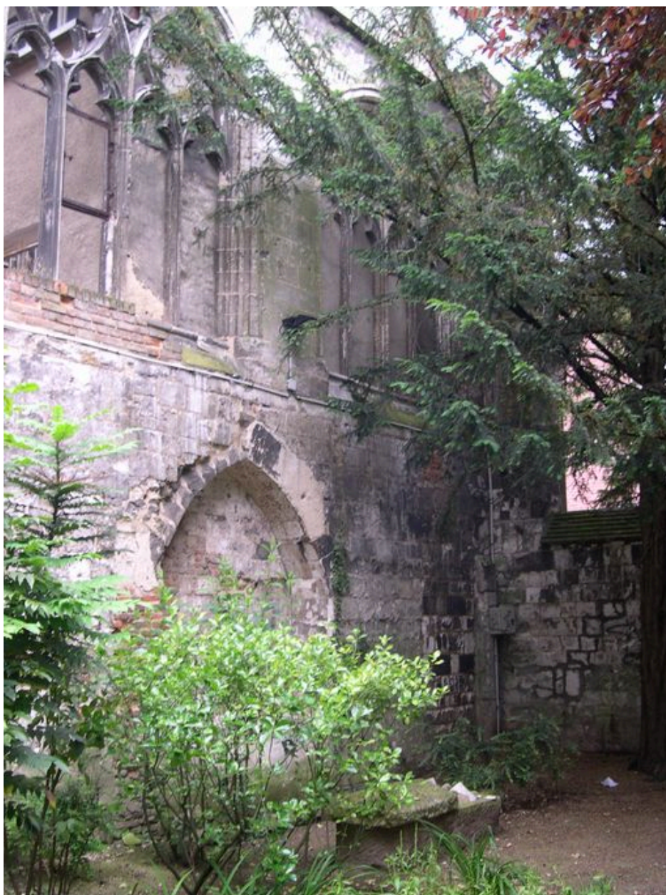
Vestiges de l'ancienne église conventuelle, vue intérieure angle sud-ouest de la nef.
