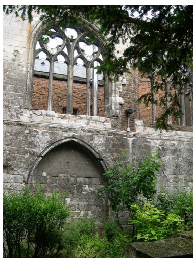
Vestiges de l'ancienne église conventuelle, vue intérieure baie du mur sud. Phot. Isabelle Barbedor IVR22_20048010828NUCA
