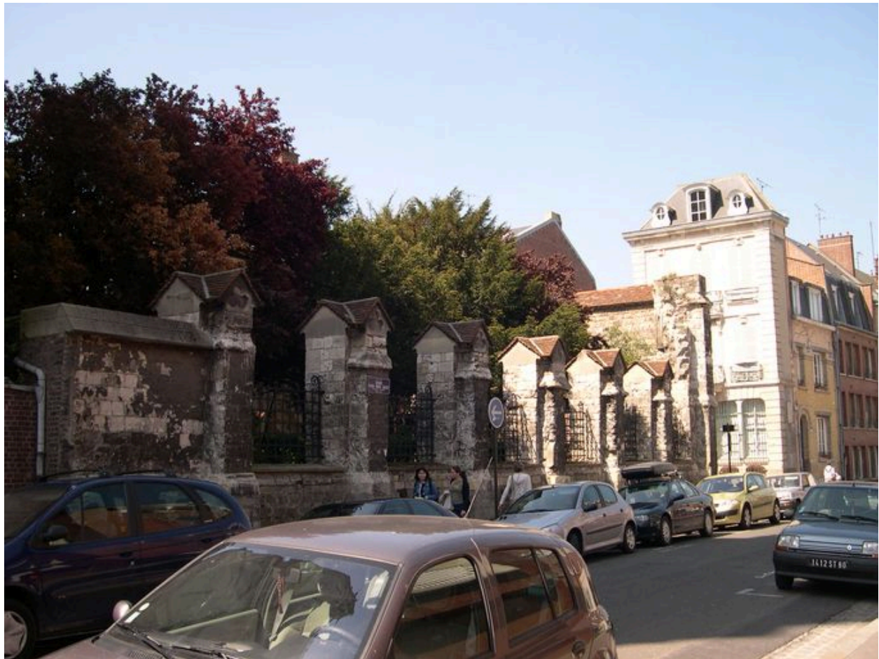
Vestiges de l'ancienne église conventuelle, façade nord.
