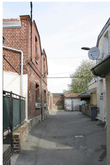
Vue prise depuis l'entrée de la cour. Phot. Frédéric Pillet IVR22_20070205167NUCA
