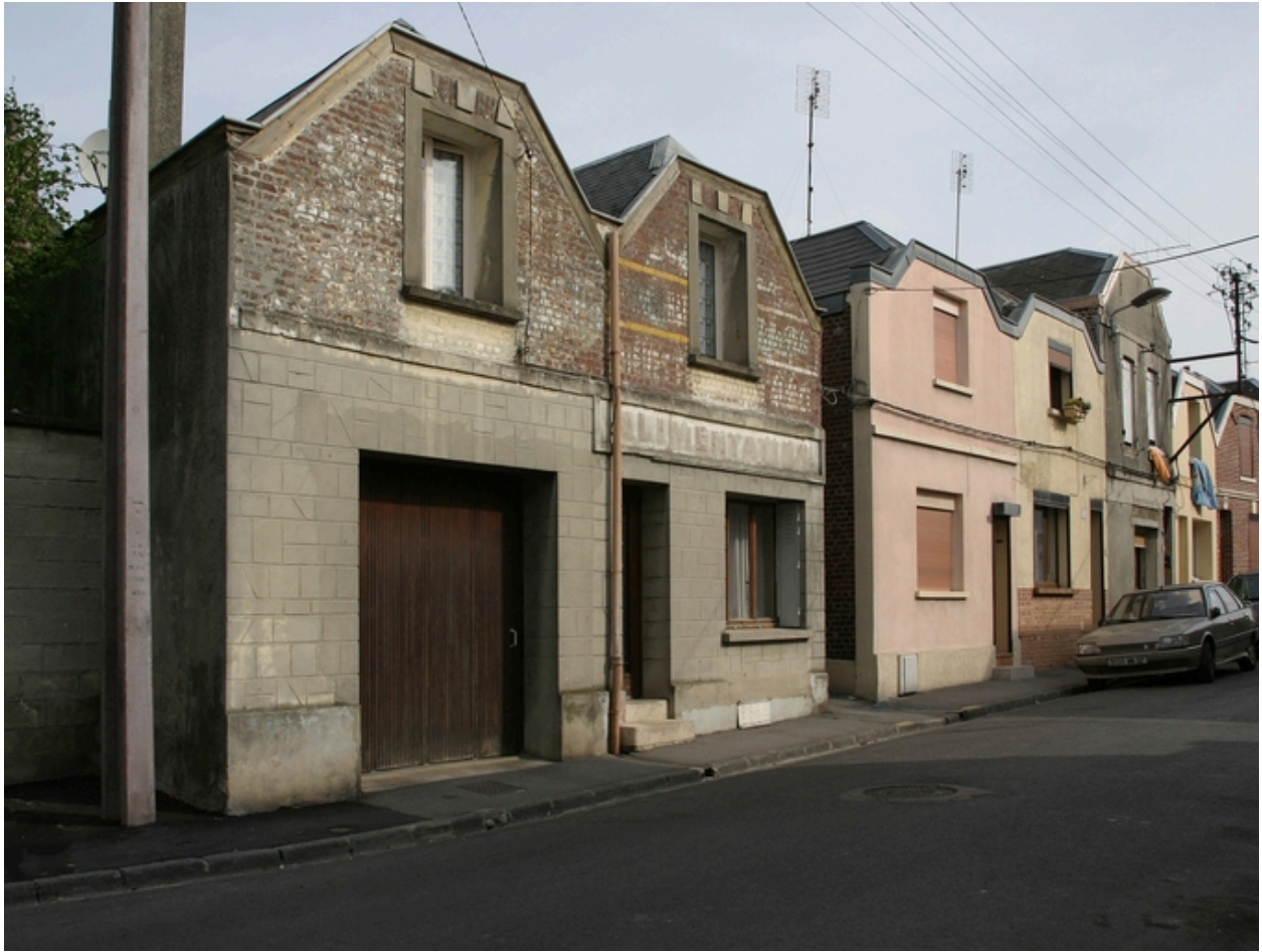
Entrée de la Cour Wavrans, rue Denfert-Rochereau, encadrée de deux habitations de part et d'autre.
