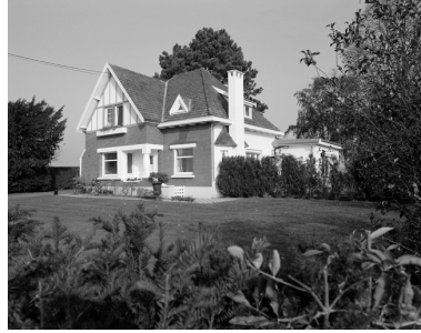
Vue générale de trois quarts. Phot. Philippe Dapvril IVR31_20045900632X
