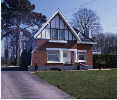
Vue générale. Phot. Pierre Thibaut IVR31_20095902001XA
