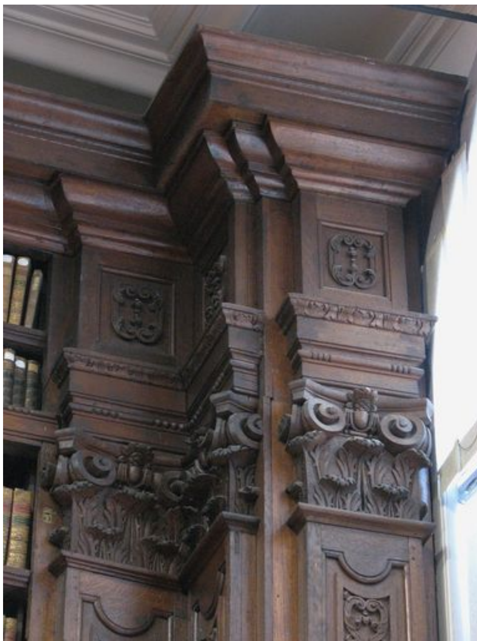
Salle de lecture, vue partielle
