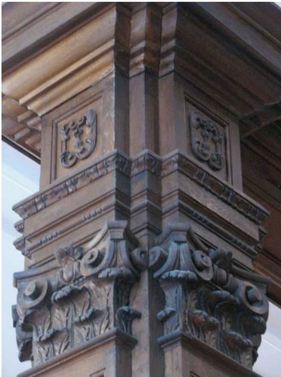
Salle de lecture, vue partielle
