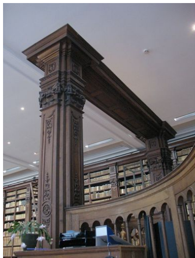
Salle de lecture, vue partielle Phot. Maya Bennani IVR31_20106203926NUCA
