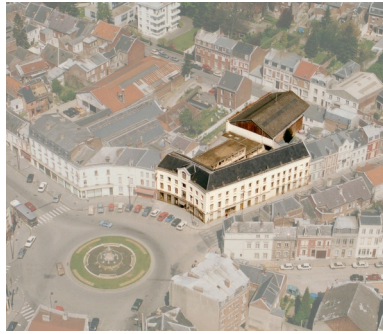
Vue aérienne du site vers 1989. Phot. Pillet Frédéric IVR22_20050206097NUCAB
