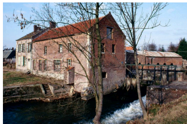
Vue d'ensemble, depuis le sud. Phot. Christiane Riboulleau IVR22_19920200408ZA
