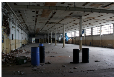
Vue intérieure des ateliers bordant la rue Turbigo. Phot. Frédéric Pillet IVR22_20060205065NUCA
