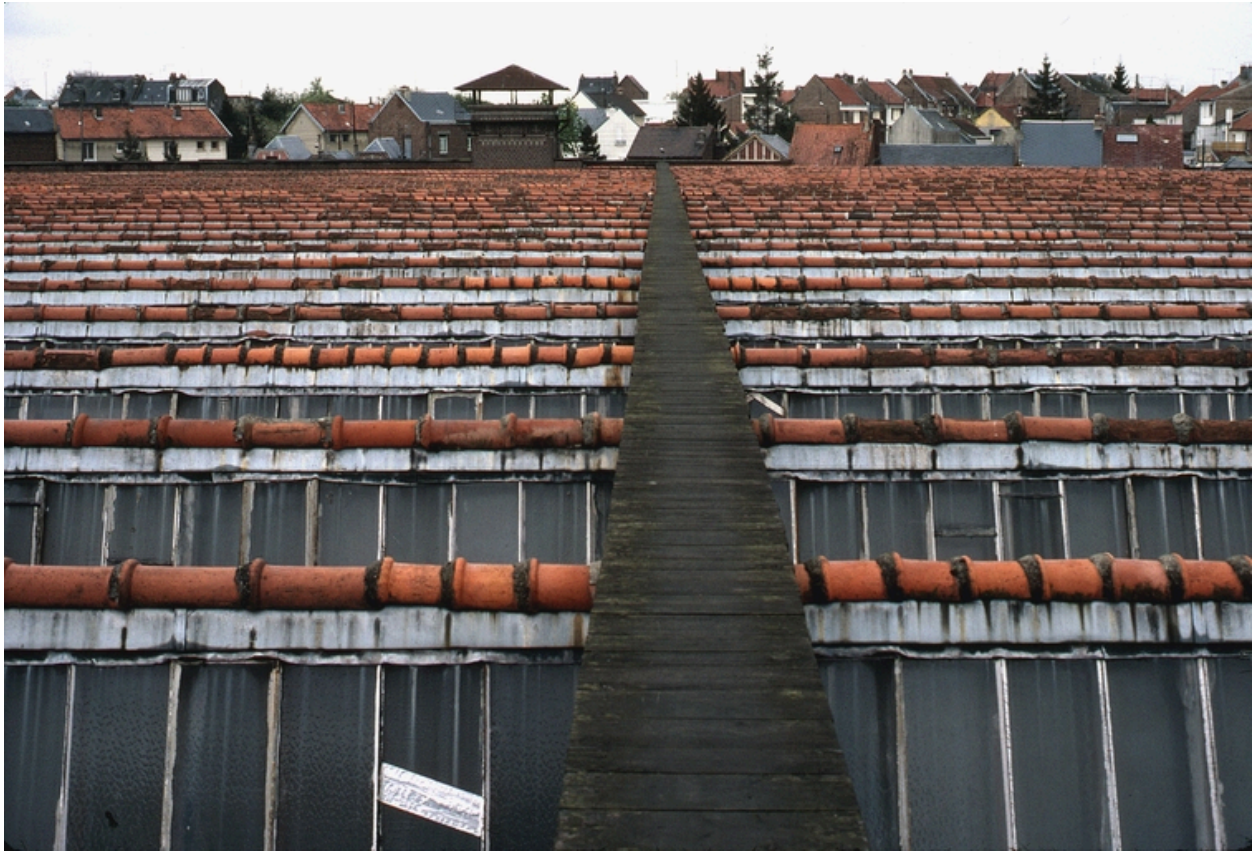
Les sheds de l'usine photographiés en direction du sud, en 1983 (BM Saint-Quentin).
