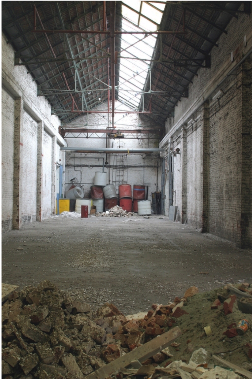
Vue intérieure de l'un des deux entrepôts de matières premières.
