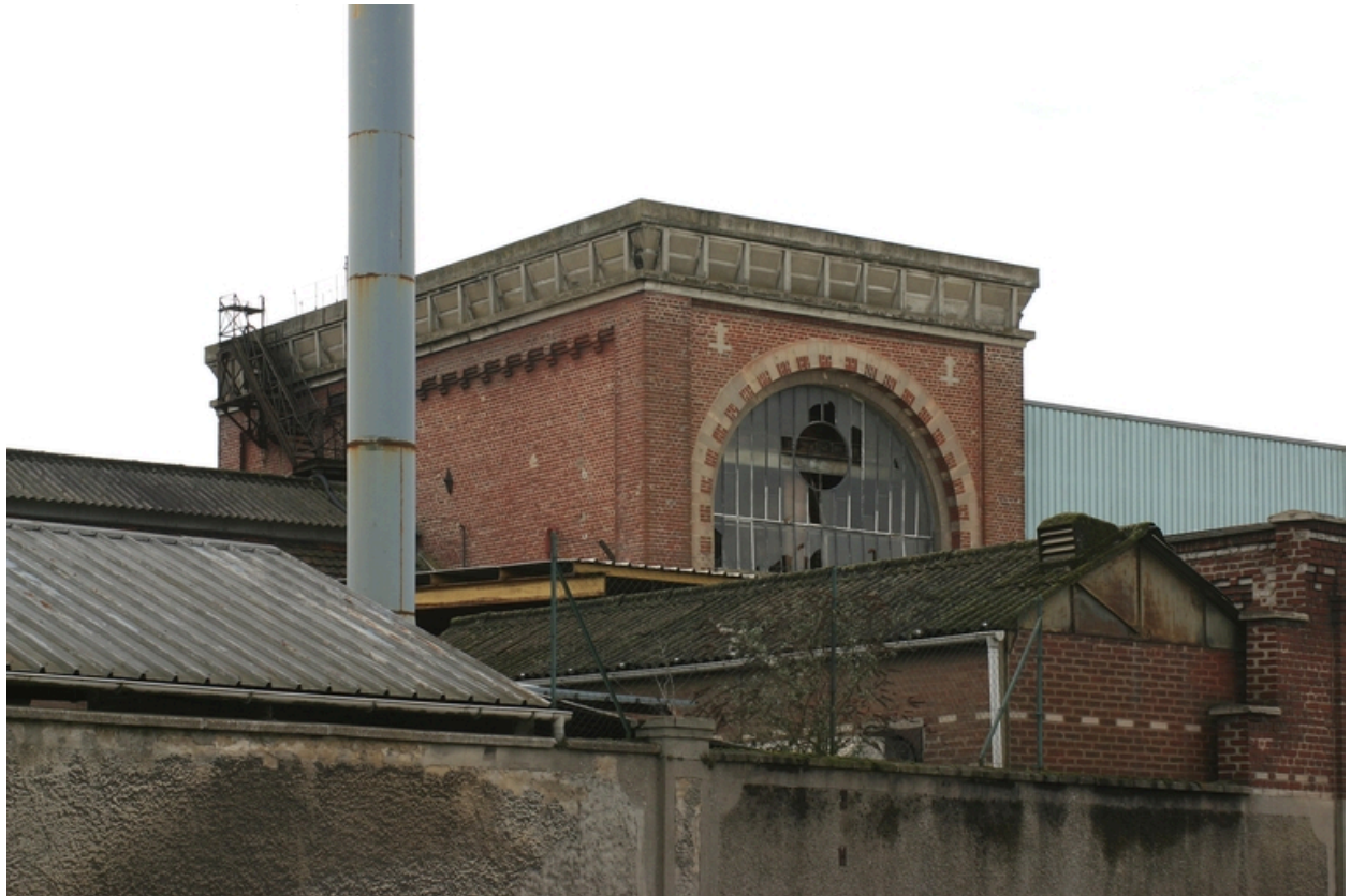
L'ancienne salle des machines vue depuis la rue de Guise.
