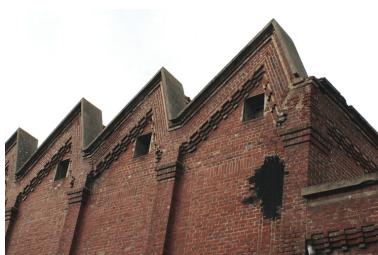
Façade des entrepôts des produits manufacturés : détail. Phot. Frédéric Pillet IVR22_20060205077NUCA
