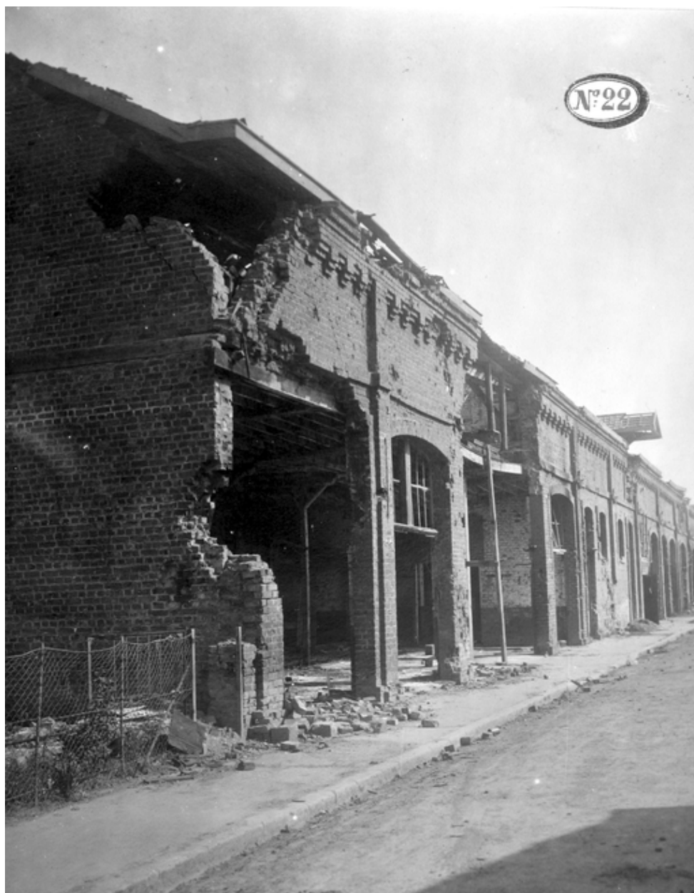
Le magasin des chaînes et déchets, vers 1919 (AD Aisne).
