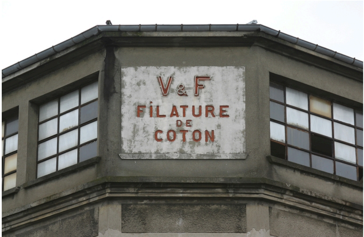
Façade de l'usine : détail.
