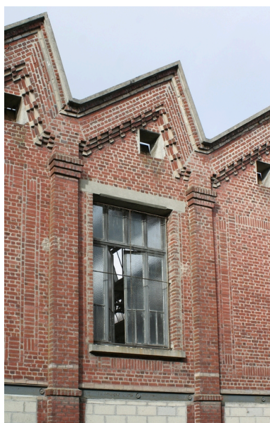
Façade des entrepôts des produits manufacturés : détail. Phot. Frédéric Pillet IVR22_20060205076NUCA
