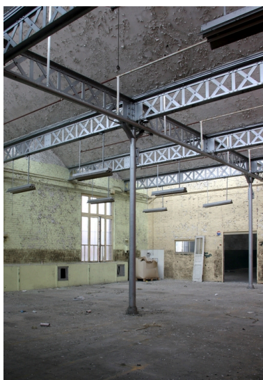
Vue intérieure des entrepôts de produits manufacturés. Phot. Frédéric Pillet IVR22_20060205080NUCA
