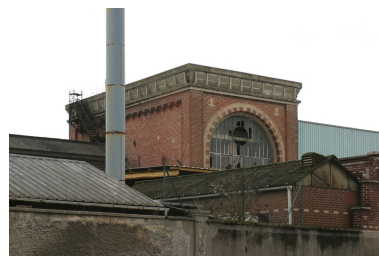
L'ancienne salle des machines vue depuis la rue de Guise. Phot. Frédéric Pillet IVR22_20060205060NUCA
