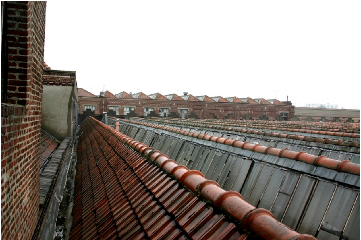
Les sheds des ateliers de 1921, vus en direction des entrepôts bordant la rue de la Convention.
