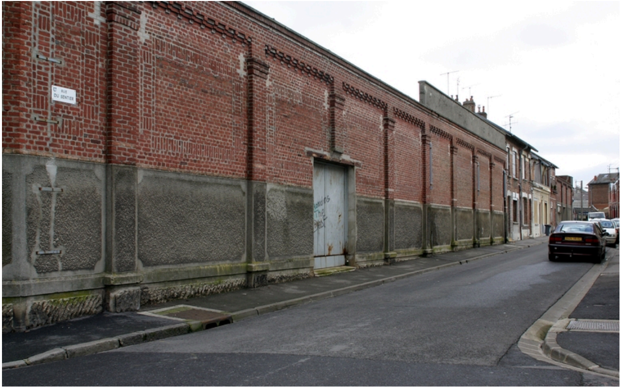
Façade de l'usine rue du Sentier.
