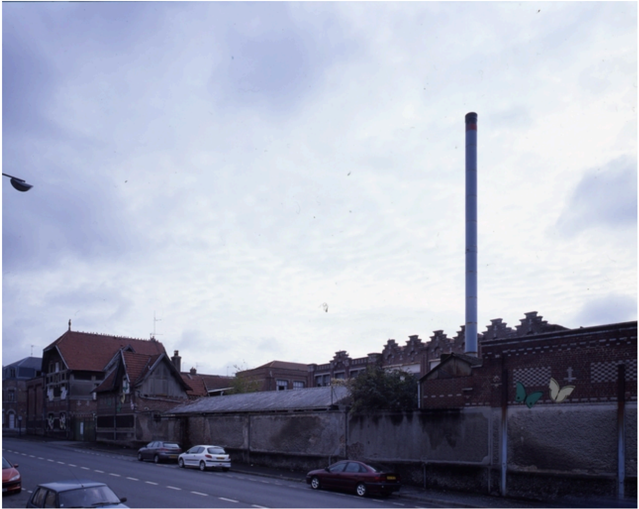
Façade de l'usine le long de la rue de Guise.
