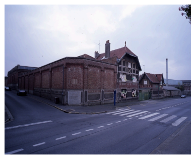
Façade de l'usine, à l'angle de la rue de la Convention et de la rue de Guise. Phot. Thierry Lefébure IVR22_20070200073VA
