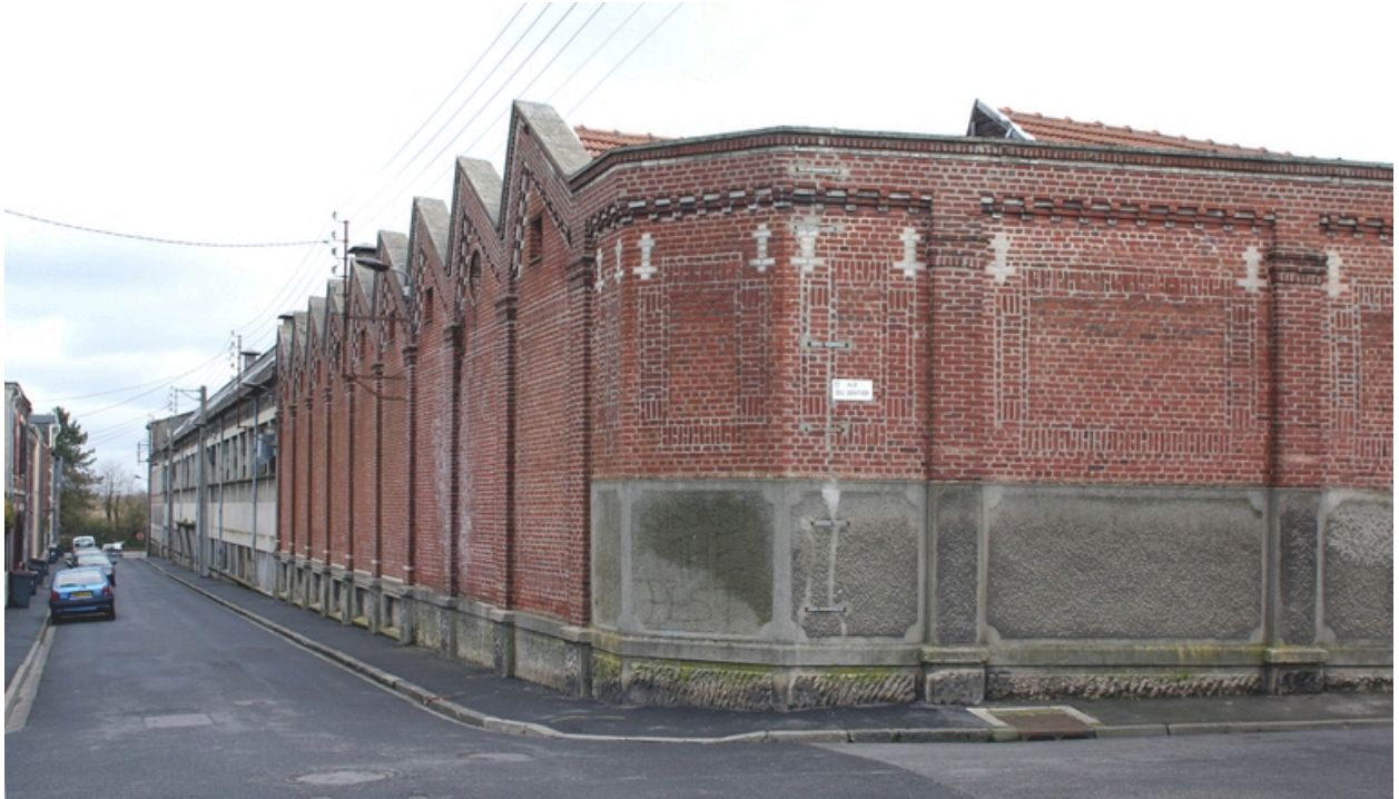
Façade de l'usine à l'angle de la rue de Turbigio et de la rue du Sentier.
