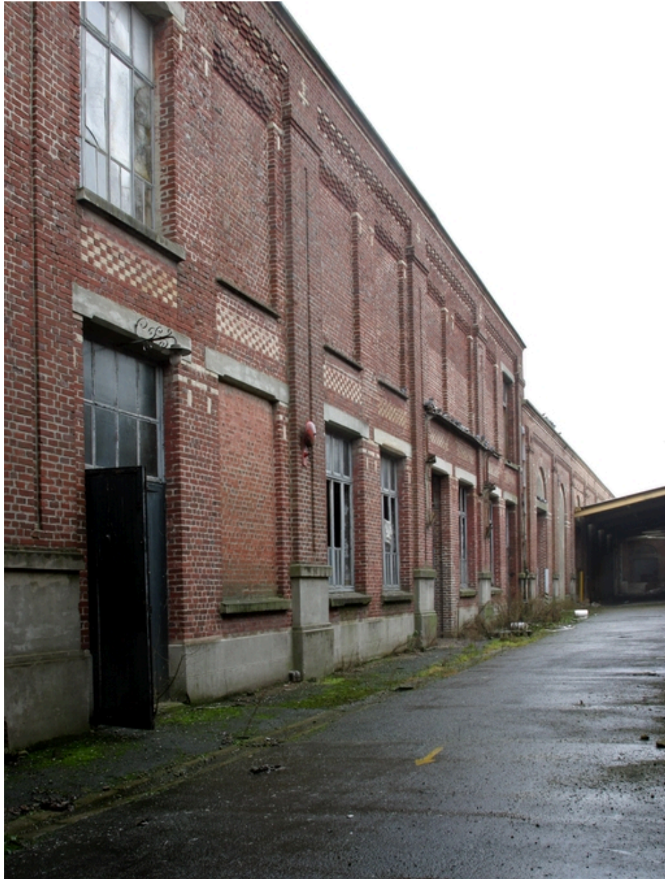
Façade sur cour des entrepôts des produits manufacturés.
