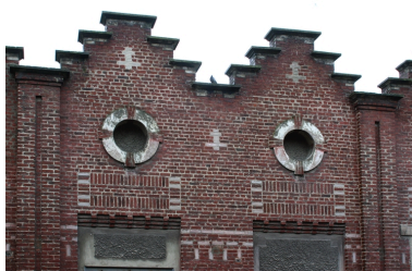
Façade des ateliers de 1921 : détail. Phot. Frédéric Pillet IVR22_20060205071NUCA
