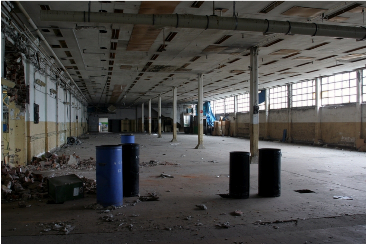
Vue intérieure des ateliers bordant la rue Turbigo.
