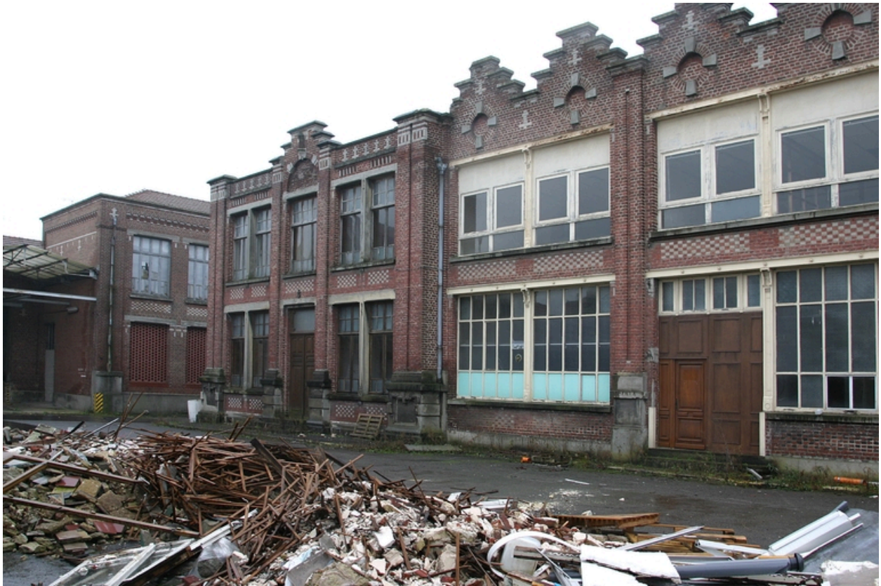
De droite à gauche : magasin d'expédition, bureaux et entrepôt des produits manufacturés.
