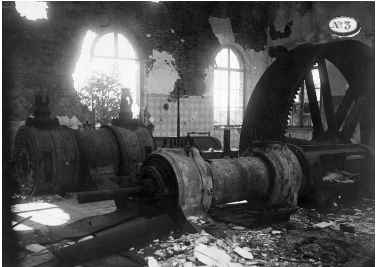
Salle des machines, vers 1919 (AD Aisne).
