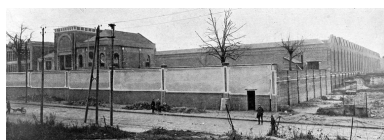
Vue de la façade antérieure de l'usine, rue de Guise, vers 1921 (Le Monde Illustré). Phot. Pillet Frédéric IVR22_20050206498NUCAB
