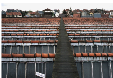
Les sheds de l'usine photographiés en direction du sud, en 1983 (BM Saint-Quentin).
