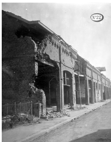
Le magasin des chaînes et déchets, vers 1919 (AD Aisne). Phot. Pillet Frédéric IVR22_20050206493NUCAB
