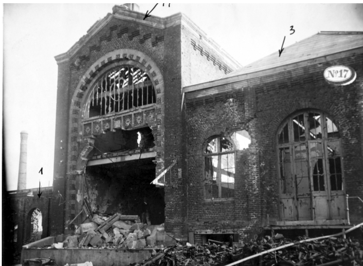
Magasin des tissus (ancienne salle des machines, à gauche) et salle des machines (à droite, 1912), vers 1919 (AD Aisne).
