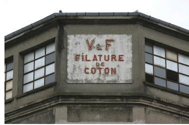
Façade de l'usine : détail. Phot. Frédéric Pillet IVR22_20060205063NUCA
