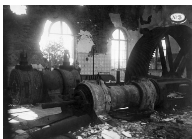
Salle des machines, vers 1919 (AD Aisne). Phot. Pillet Frédéric IVR22_20050206495NUCAB
