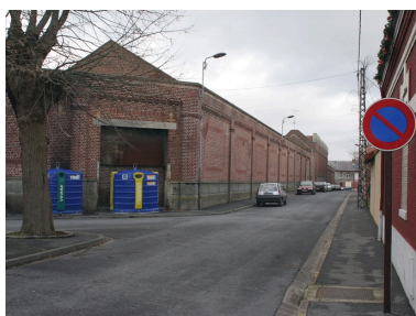
Façade de l'usine rue de la Convention. Phot. Frédéric Pillet IVR22_20060205074NUCA
