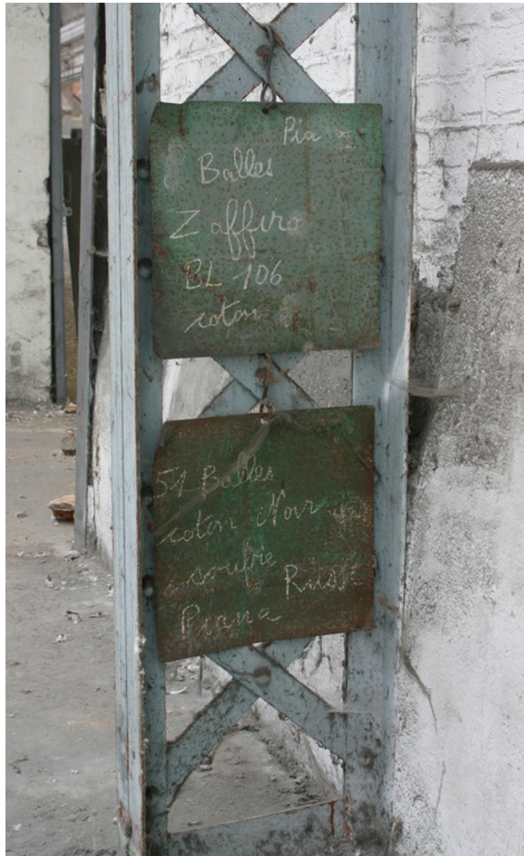
Entrepôt des matières premières : détail.
