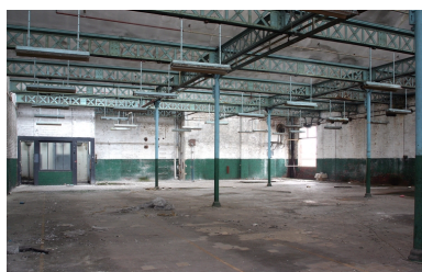
Vue intérieure des entrepôts de produits manufacturés. Phot. Frédéric Pillet IVR22_20060205079NUCA
