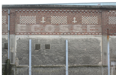
Détail du mur d'enceinte, rue de Guise. Phot. Frédéric Pillet IVR22_20060205061NUCA
