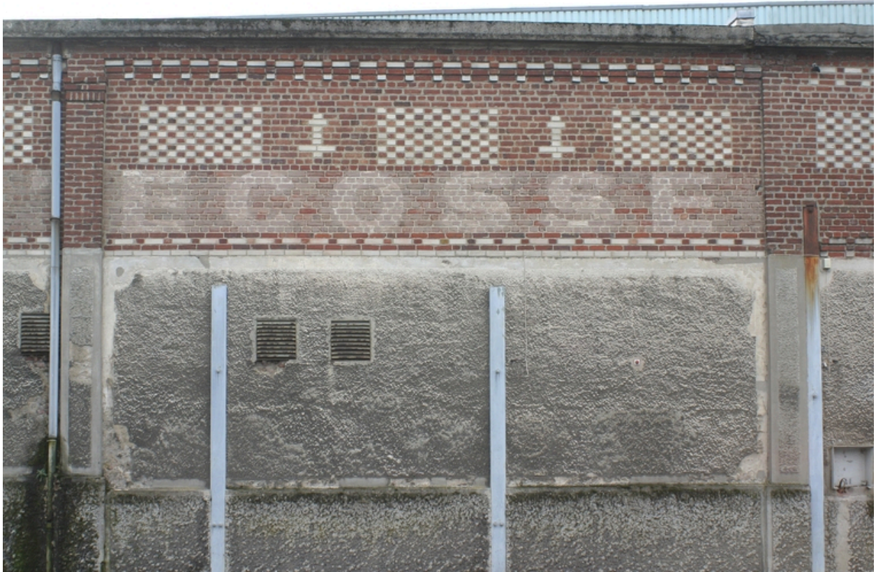
Détail du mur d'enceinte, rue de Guise.
