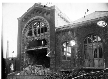
Magasin des tissus (ancienne salle des machines, à gauche) et salle des machines (à droite, 1912), vers 1919 (AD Aisne). Phot. Pillet Frédéric IVR22_20050206494NUCAB
