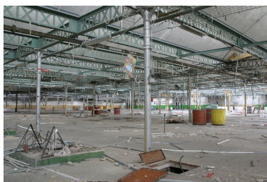
Vue intérieure des ateliers de 1921. Phot. Frédéric Pillet IVR22_20060205068NUCA
