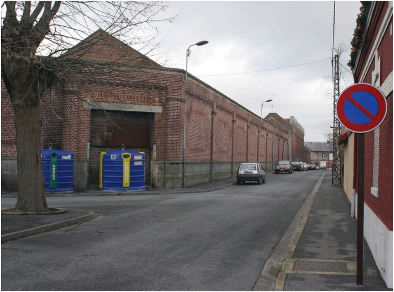
Façade de l'usine rue de la Convention.
