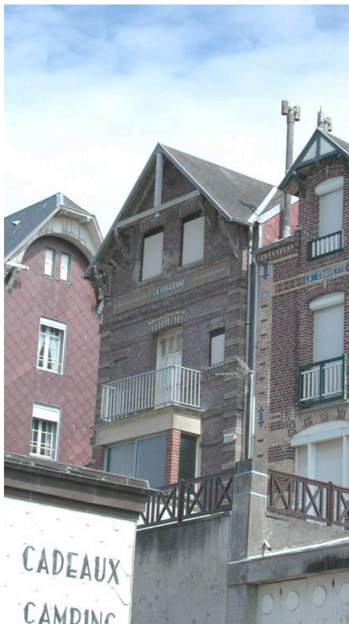
Vue d'ensemble depuis la rue de Saint-Valery, côté mer (villa de gauche).
