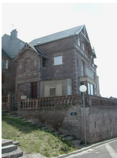
Vue de trois-quarts sur les élévations antérieure et latérale gauche, depuis la rue des Architectes. Phot. Elisabeth Justome IVR22_20048001547NUCA
