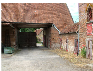
Etables dans le prolongement du passage charretier. Phot. Frédéric Fournis IVR22_20108001943NUCA
