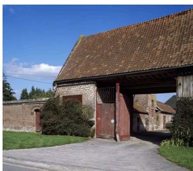
Porte et passage charretiers. Phot. Marie-Laure Monnehay-Vulliet IVR22_20108000358XA
