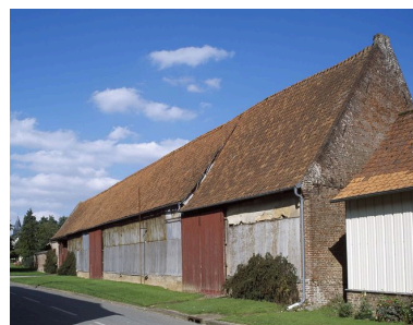
Vue générale depuis la rue. Phot. Marie-Laure Monnehay-Vulliet IVR22_20108000357XA
