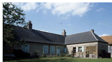
Vue arrière du logis sur jardin. Phot. Marie-Laure Monnehay-Vulliet IVR22_20108000353XA
