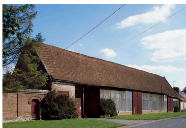
Vue générale depuis la rue. Phot. Marie-Laure Monnehay-Vulliet IVR22_20108000360XA
