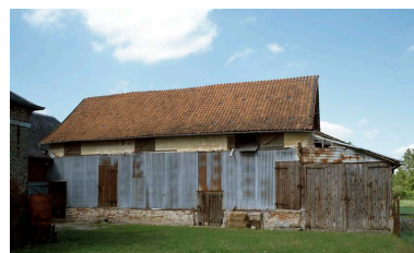
Grange en retour d'équerre sur le jardin. Phot. Marie-Laure Monnehay-Vulliet IVR22_20108000351XA
