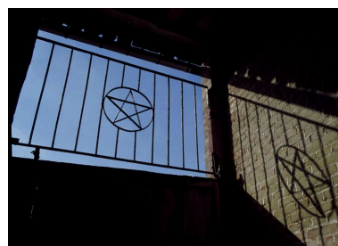
Imposte de la porte charretière. Phot. Marie-Laure Monnehay-Vulliet IVR22_20108000361XA
