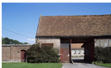
Porte et passage charretiers. Phot. Marie-Laure Monnehay-Vulliet IVR22_20108000359XA
