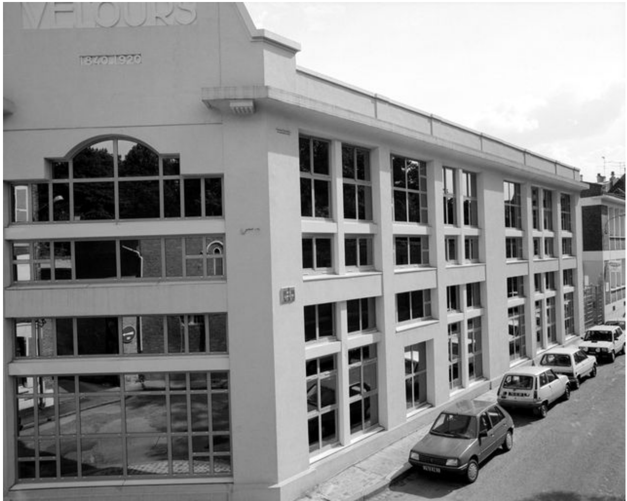
Atelier principal, façade sur la rue de Corbie.
