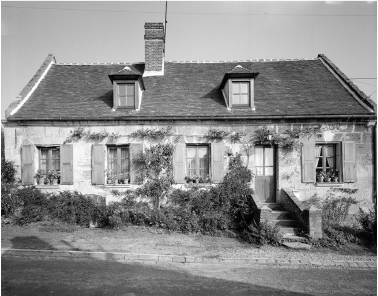
Logis. Vue générale.
