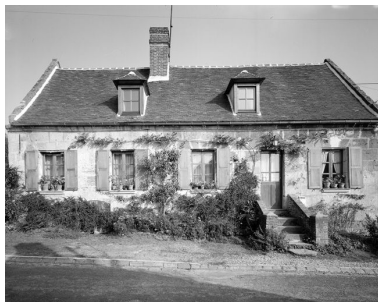
Logis. Vue générale. Phot. Jean-Michel Perrin IVR22_19846001226V
