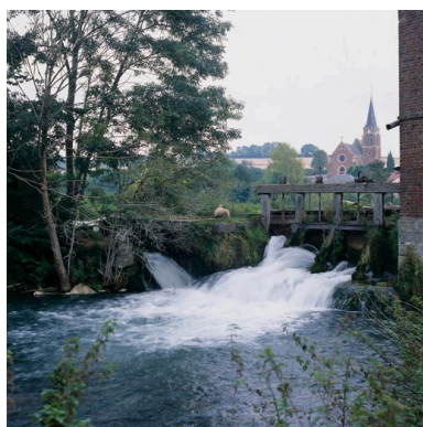
Le vannage de décharge.
