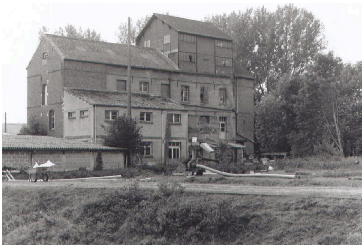
Ensemble postérieur de la minoterie.
