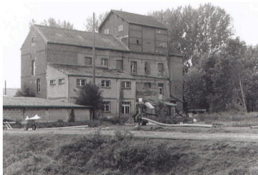
Ensemble postérieur de la minoterie.
