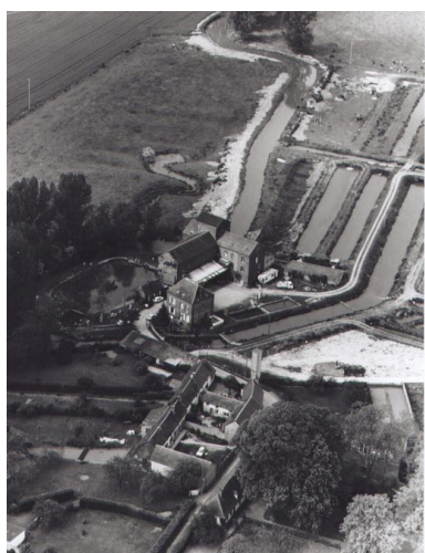
Vue aérienne de l'usine en 1994. Phot. Phot'R
