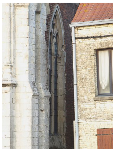
Fenêtre du bas-côté sud : mur en brique et encadrement en pierre calcaire Phot. Bruno Decrock IVR31_20106202621NUCA
