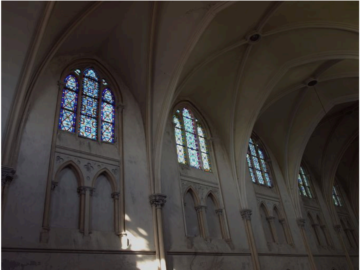
Fenêtres hautes placées au-dessous de deux arcades aveugles par travée formant triforium partiel
