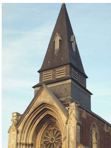
Tour et flèche de façade, construite en 1935 Phot. Bruno Decrock IVR31_20106202617NUCA
