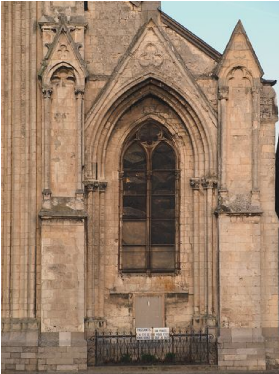
Baie occidentale du bas-côté sud
