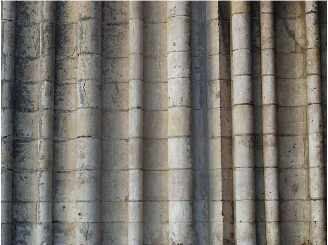
Détail des colonnettes des ébrasements du portail ouest (côté nord)
