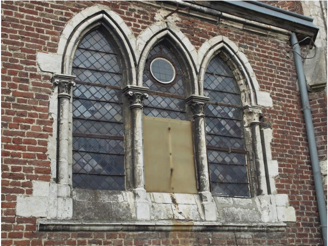
Triplet de la sacristie (mur est)
