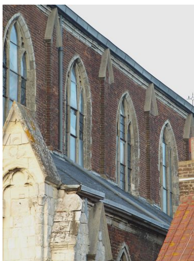
Fenêtres hautes de la nef : mur en brique et encadrements des baies et chapérons des contreforts en pierre calcaire Phot. Bruno Decrock IVR31_20106202622NUCA
