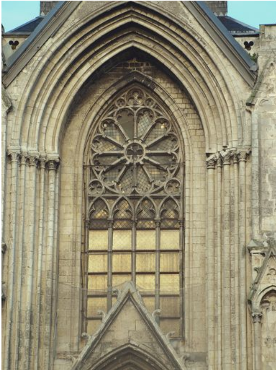
Verrière haute de la façade, prise dans une paroi largement ébrasée
