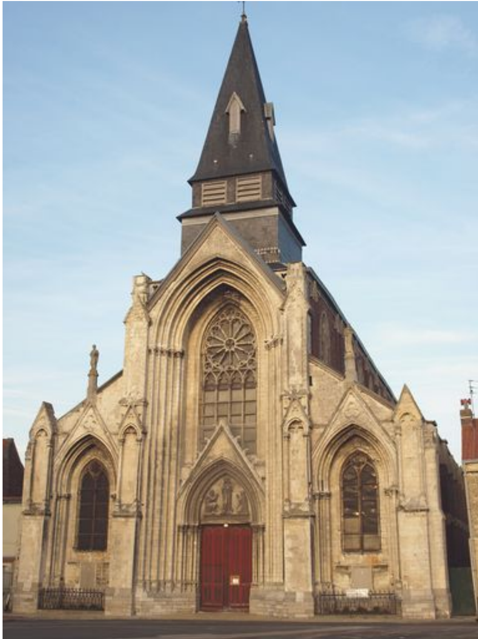
Vue générale de la façade
