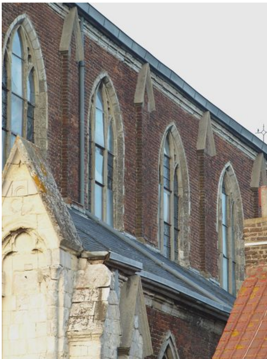
Fenêtres hautes de la nef : mur en brique et encadrements des baies et chaperons des contreforts en pierre calcaire
