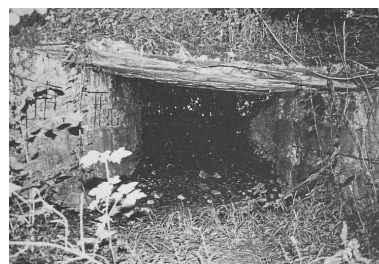
Vue d'un abri en béton armé. Phot. Inès Guérin IVR22_20030203036NUCAB
