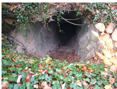
Vue de l'entrée du tunnel. Phot. Inès Guérin IVR22_20030202932NUCA
