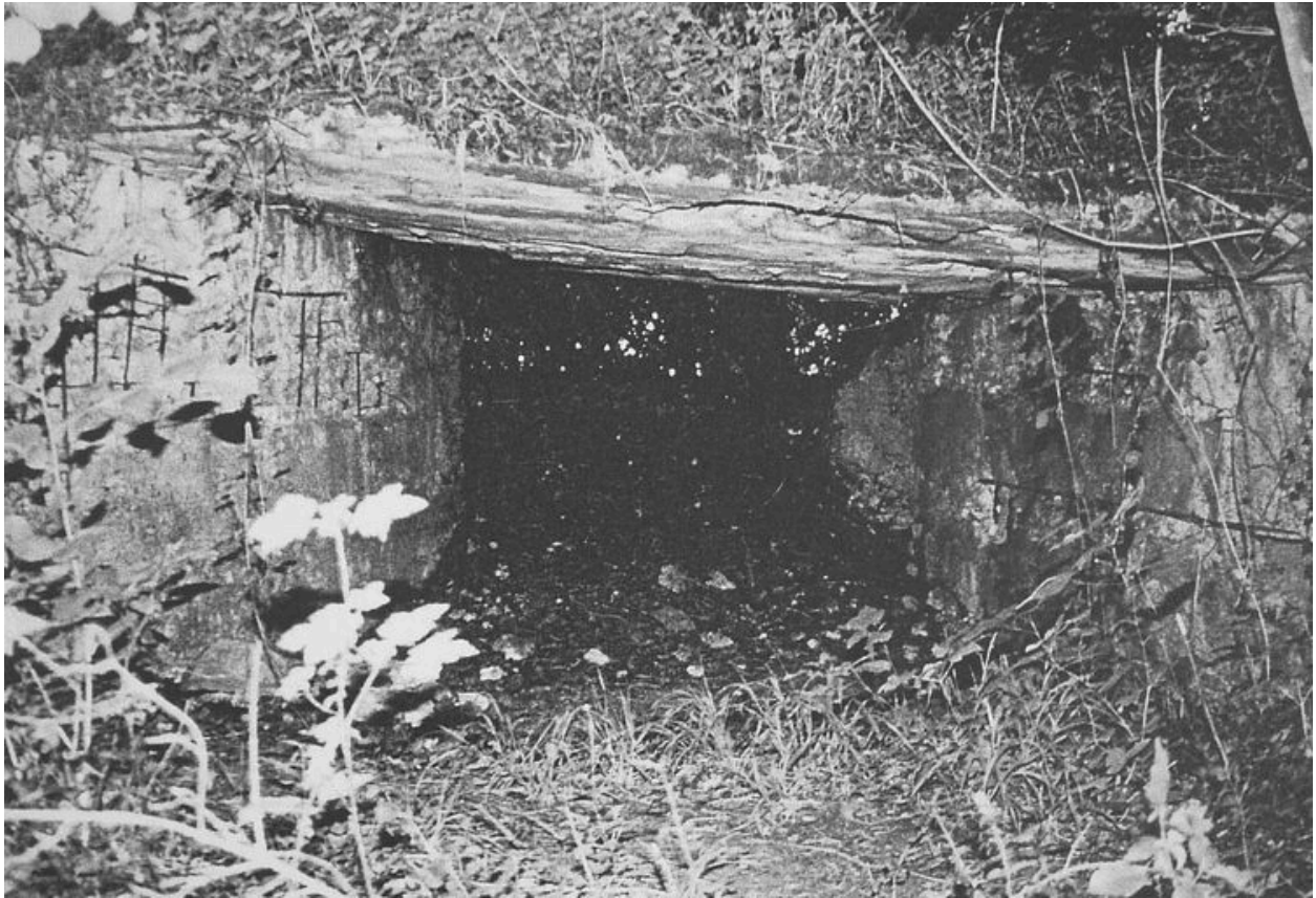
Vue d'un abri en béton armé.
