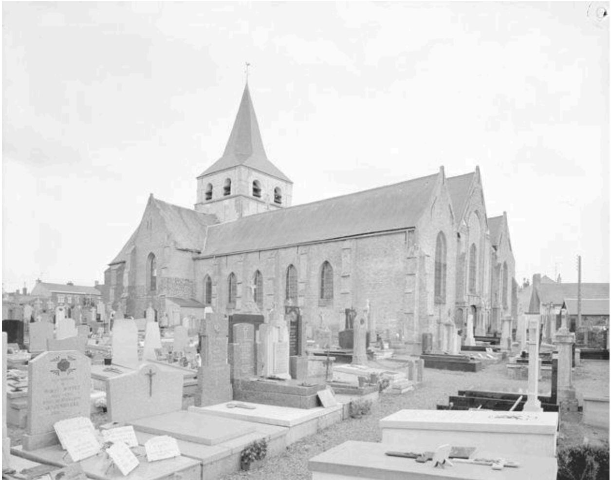
Vue générale de la façade nord.
