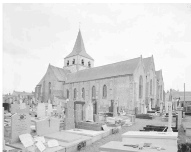
Vue générale de la façade nord. Phot. Philippe Dapvril IVR31_19905900981V
