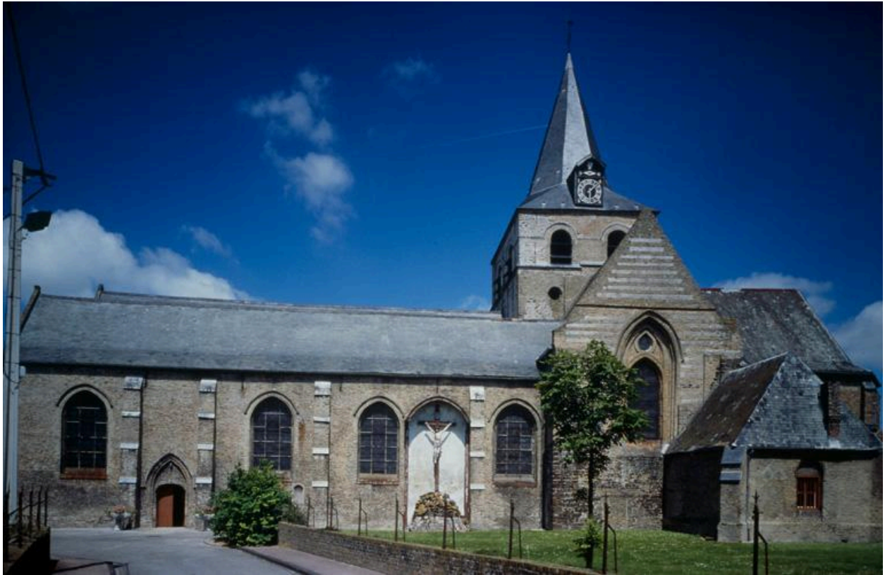
Vue générale de la façade sud.
