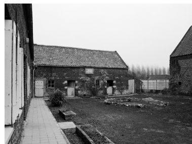
Ferme en U, 16, rue Deken, grange perpendiculaire et étables-écuries parallèles à la rue. Phot. Philippe Dapvril IVR31_20055900490X
