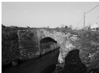
Le ponceau de la Caterie, vue générale. Phot. Philippe Dapvril IVR31_20055900161X
