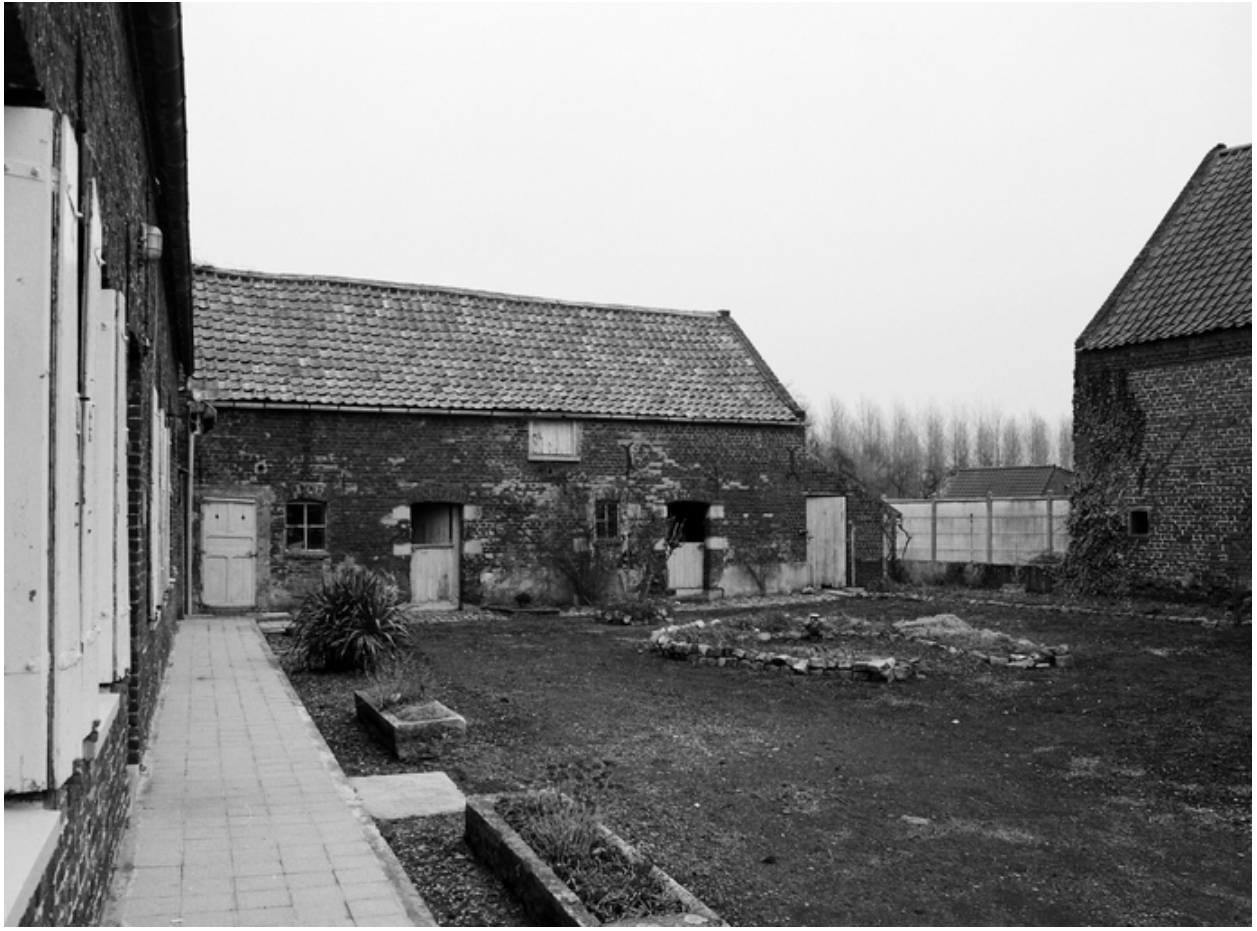
Ferme en U, 16, rue Deken, grange perpendiculaire et étables-écuries parallèles à la rue.
