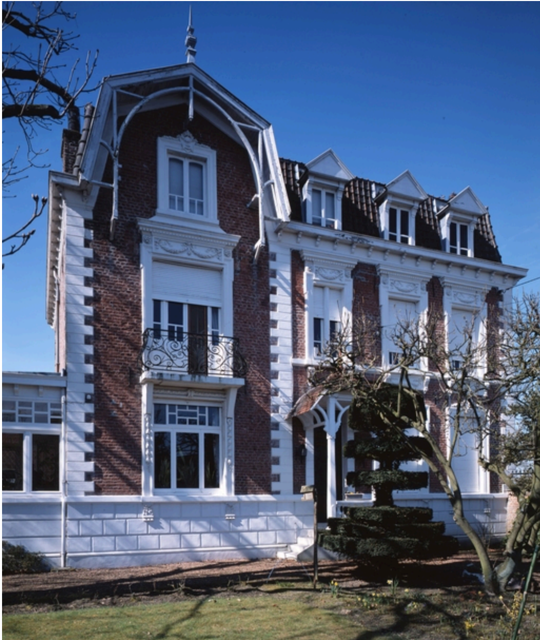
Maison bourgeoise située 163, rue Delannoy, vue générale.
