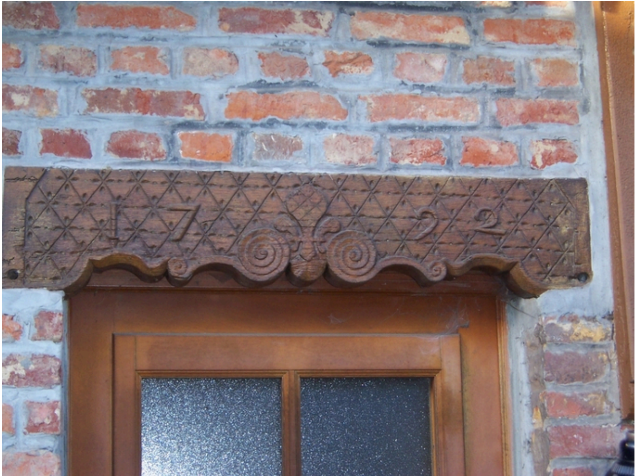
Atelier de menuisier, 249, rue des Rosiers, le linteau.
