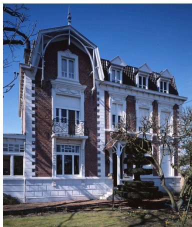
Maison bourgeoise située 163, rue Delannoy, vue générale. Phot. Pierre Thibaut IVR31_20095901350VA
