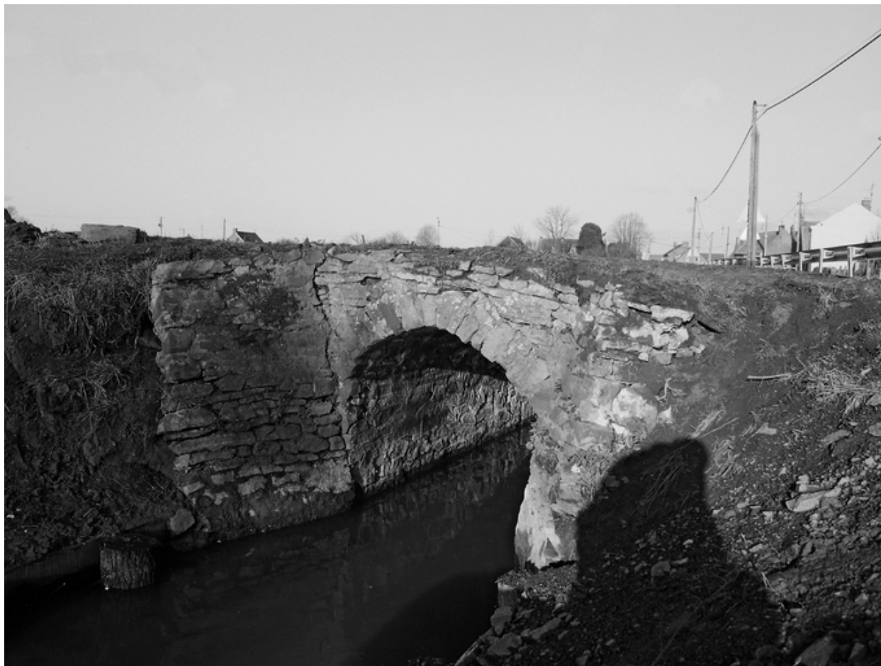
Le ponceau de la Caterie, vue générale.
