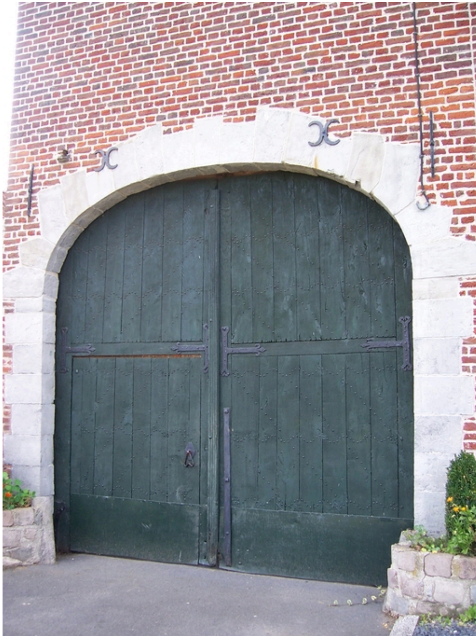
Porte charretière, 190 avenue du Général-Leclerc.
