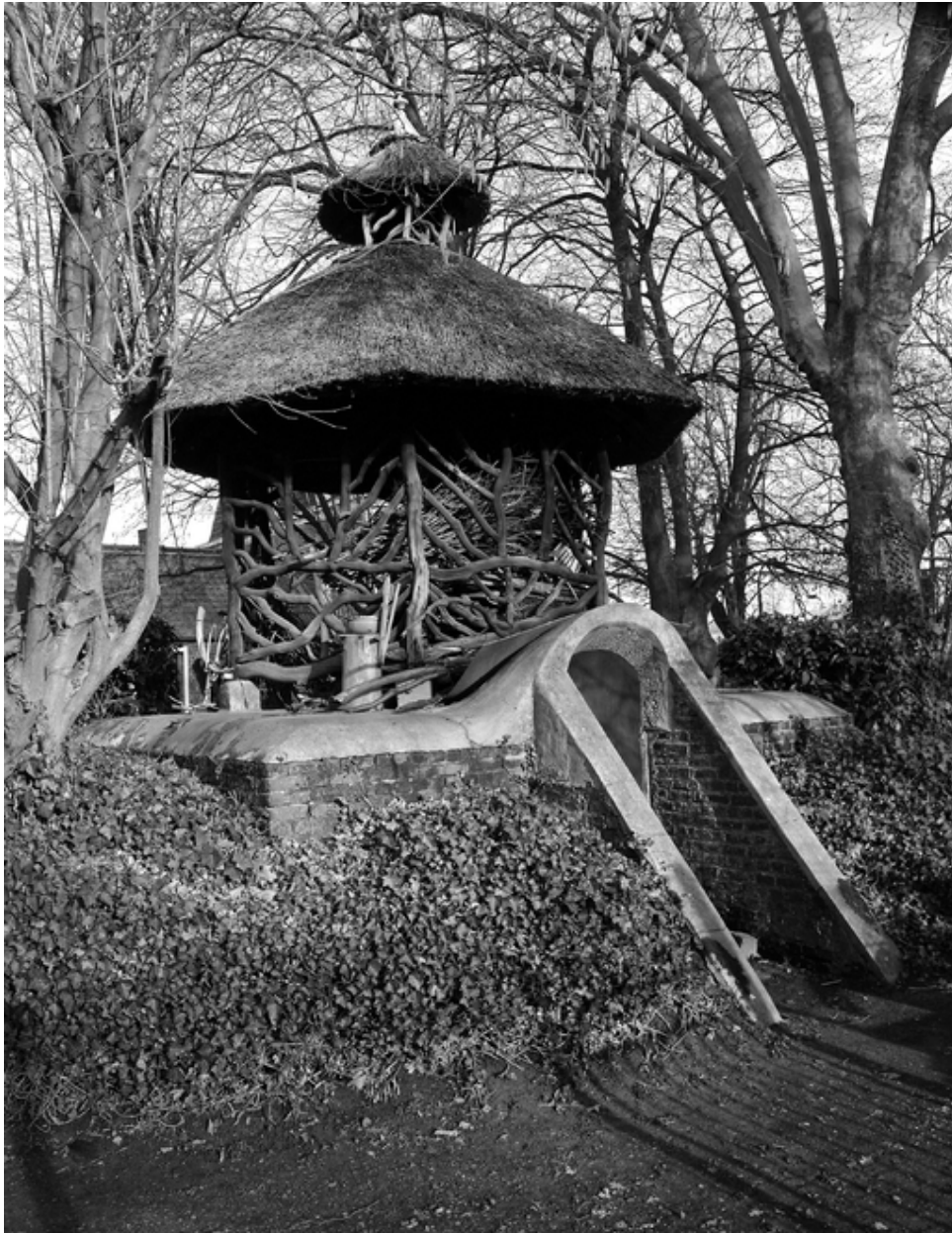
La fabrique de jardin (gloriette) du 163, rue Delannoy.
