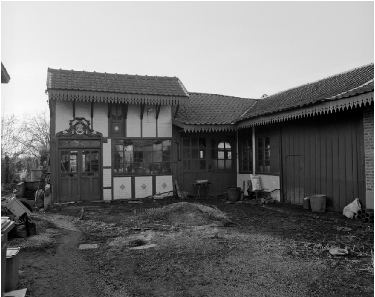
Atelier de menuisier, 249, rue des Rosiers, vue générale.
