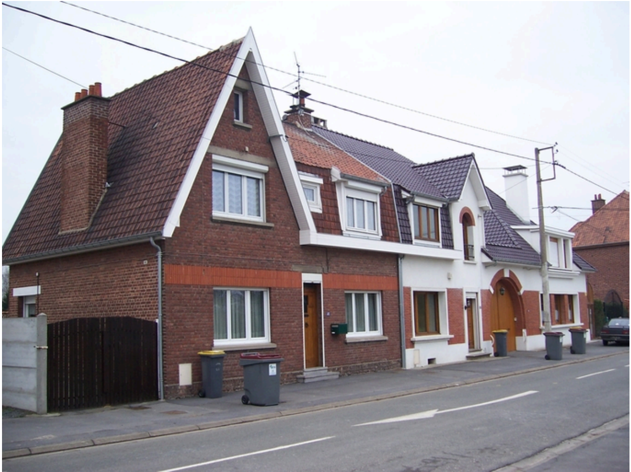
Maisons reconstruites, 55 et 59 rue des Soeurs-Liesse.
