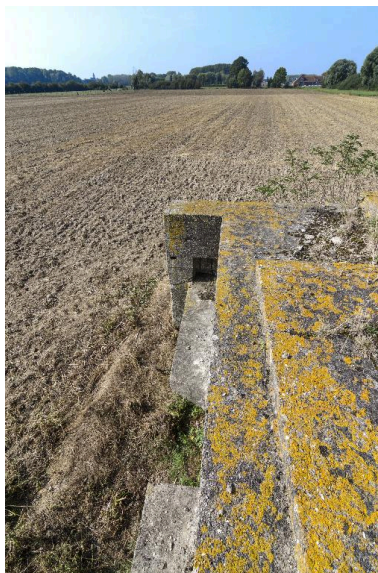
Depuis le couvrement, banquette de tir et position de la mitrailleuse ouest Phot. Jean-Marc Ramette IVR32_20175901069NUCA
