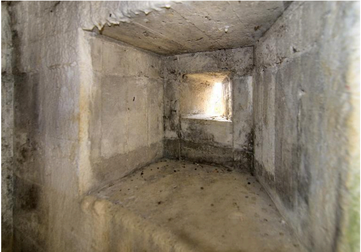
Depuis le couloir de distribution, créneau de fusillade couvrant les abords sud de l'édifice
