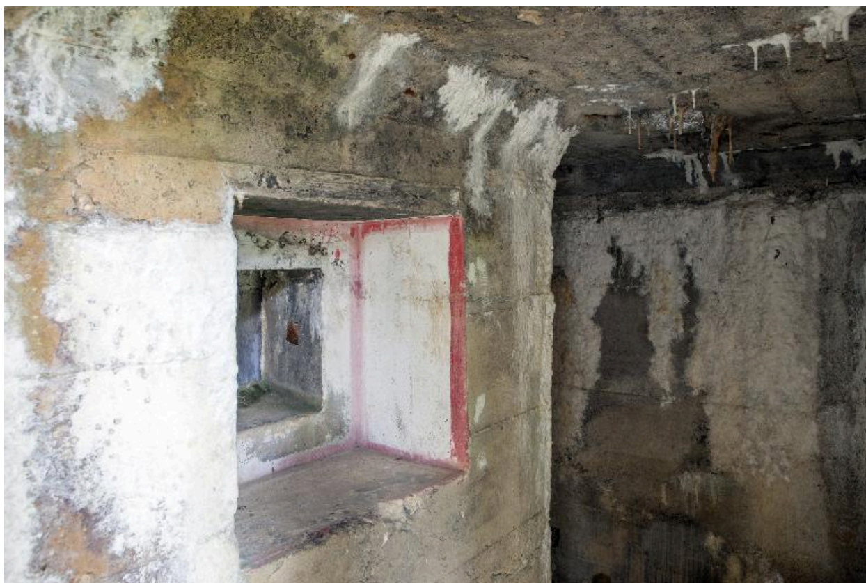
Depuis le couloir de distribution, créneau de fusillade couvrant l'entrée
