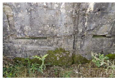
Elévation postérieure. Embrasures de surveillance (?) Phot. Jean-Marc Ramette IVR32_20175901070NUCA
