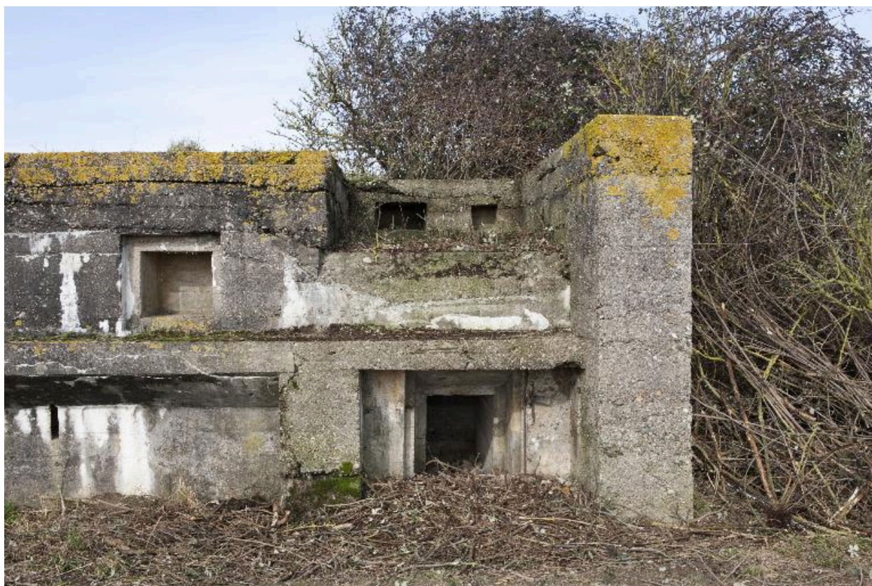
Emplacement de la mitrailleuse droite. Position de tir sur le couverture avec ses niches à munitions, resserre de la mitrailleuse dans la partie basse
