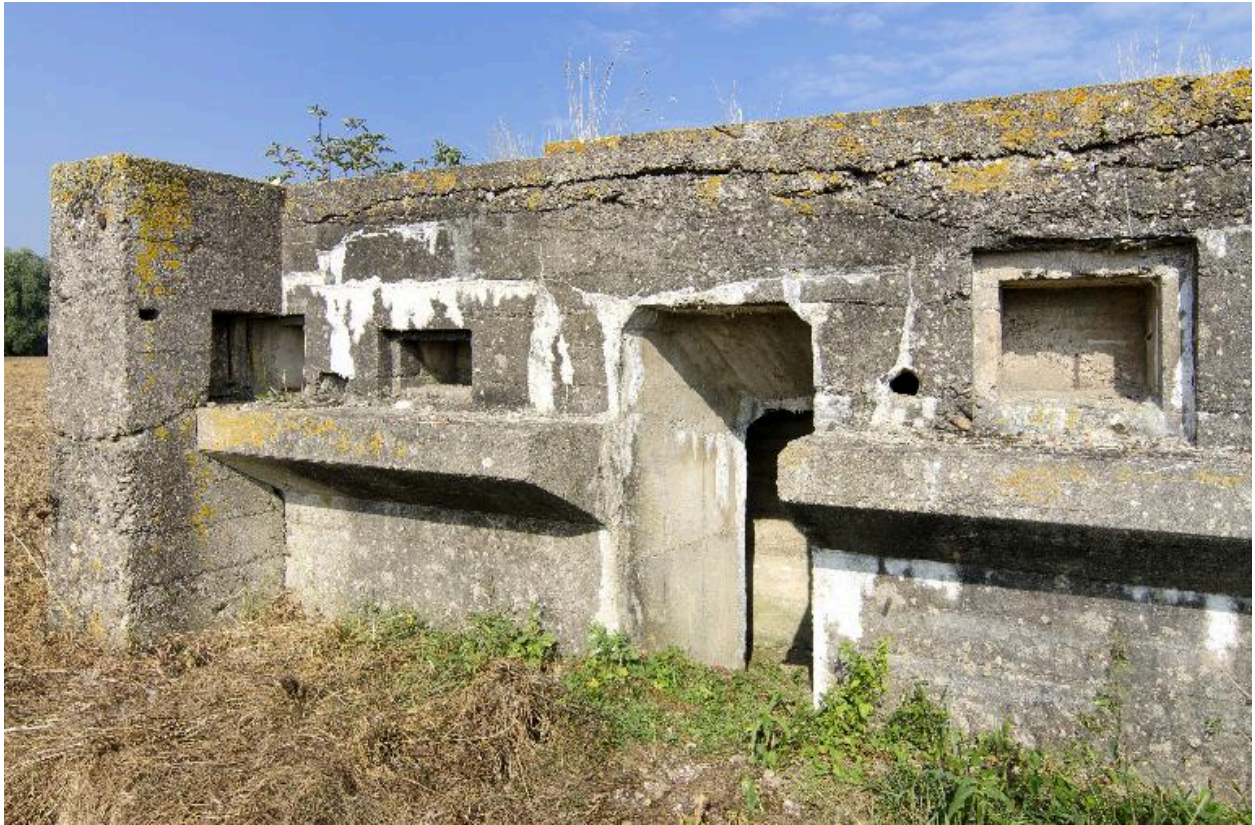
Partie ouest de l'édifice. Banquette de tir pour la seconde mitrailleuse et niches à munitions encadrant l'entrée
