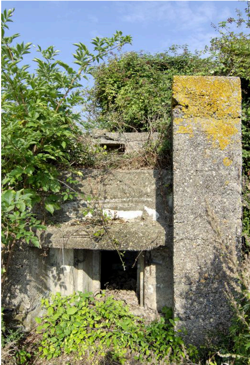
Position de tir sur le couverture et resserre de la mitrailleuse dans la partie basse
