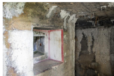
Depuis le couloir de distribution, créneau de fusillade couvrant l'entrée Phot. Jean-Marc Ramette IVR32_20165900949NUCA
