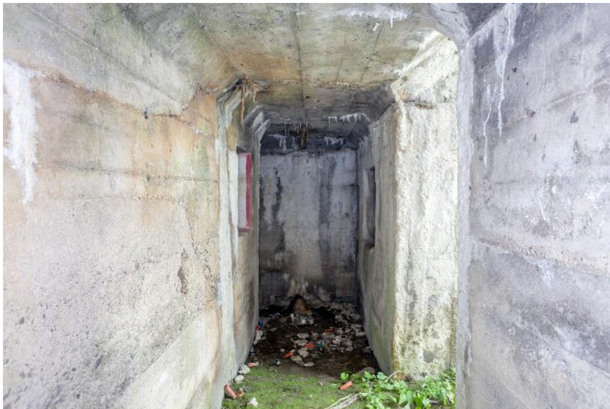
Couloir de distribution, vers l'est
