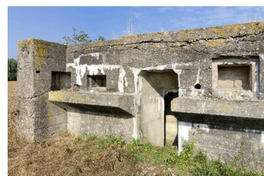
Partie ouest de l'édifice. Banquette de tir pour la seconde mitrailleuse et niches à munitions encadrant l'entrée Phot. Jean-Marc Ramette IVR32_20175901068NUCA
