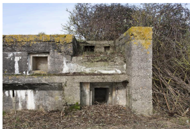
Emplacement de la mitrailleuse droite. Position de tir sur le couvrement avec ses niches à munitions, resserre de la mitrailleuse dans la partie basse Phot. Pierre Thibaut IVR32_20165900537NUCA
