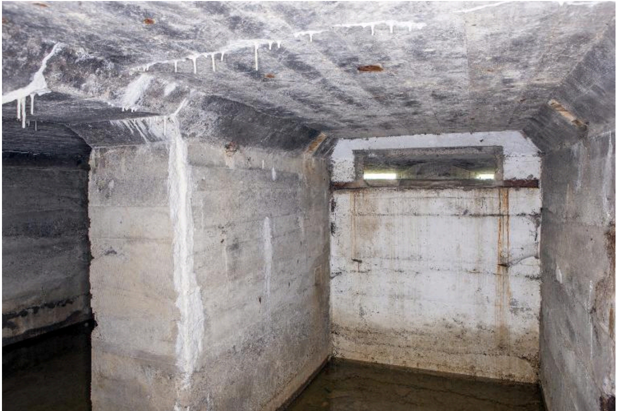
Salle est avec son poste de surveillance (?)
