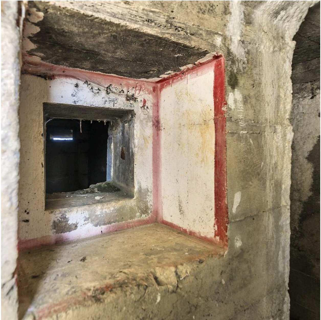
Depuis le couloir de distribution, détail du créneau de fusillade couvrant l'entrée
