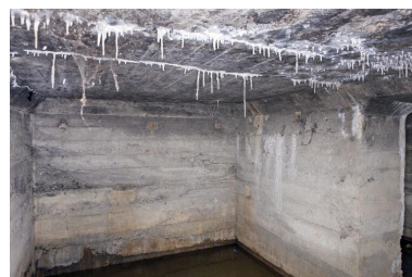
Salle ouest Phot. Pierre Thibaut IVR32_20165900947NUCA
