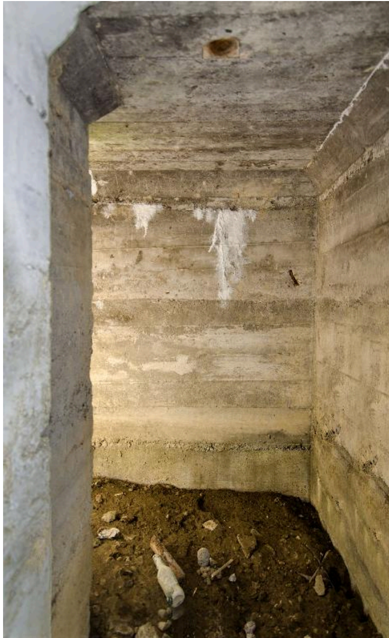
Passage de la salle ouest au couloir de distribution
