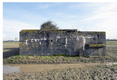
Vue latérale, vers l'est Phot. Pierre Thibaut IVR32_20165900530NUCA
