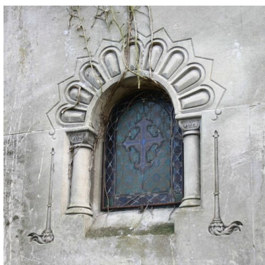
Fenêtre cintrée, ouvrant les murs latéraux du tombeau-chapelle. Phot. Caroline Vincent IVR22_20078001322NUCA
