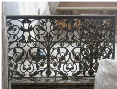
Vue générale, pan latéral gauche Phot. Bruno Decrock IVR31_20106202016NUCA
