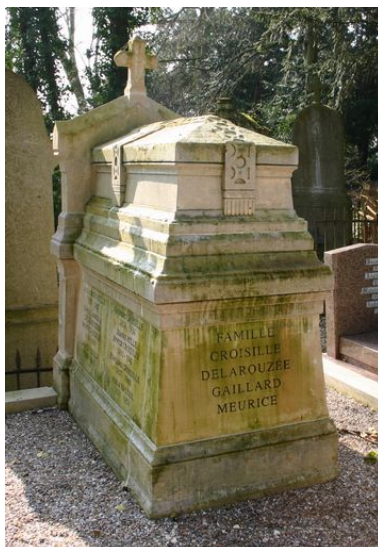
Tombeau en forme de catafalque, vers 1867-1881. Phot. Caroline Vincent IVR22_20098001056NUCA
