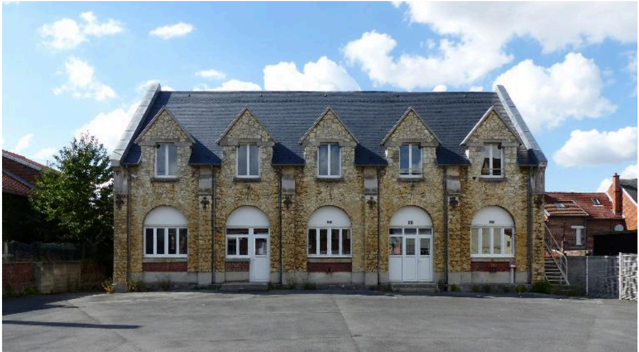
Vue de la maison paroissiale.
