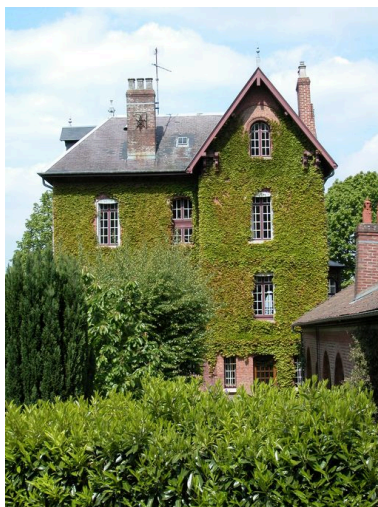
Elévation postérieure. Phot. Elisabeth Justome IVR22_20058002858NUCA
