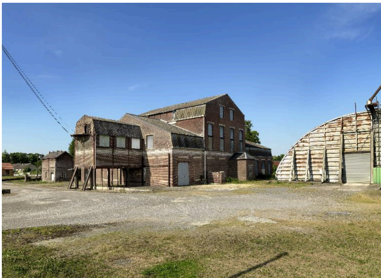
Vue d'ensemble nord-ouest de la râperie.
