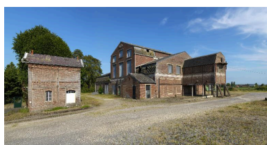
Vue d'ensemble de la râperie. Phot. Thierry Lefébure IVR22_20158000294NUC2AQ
