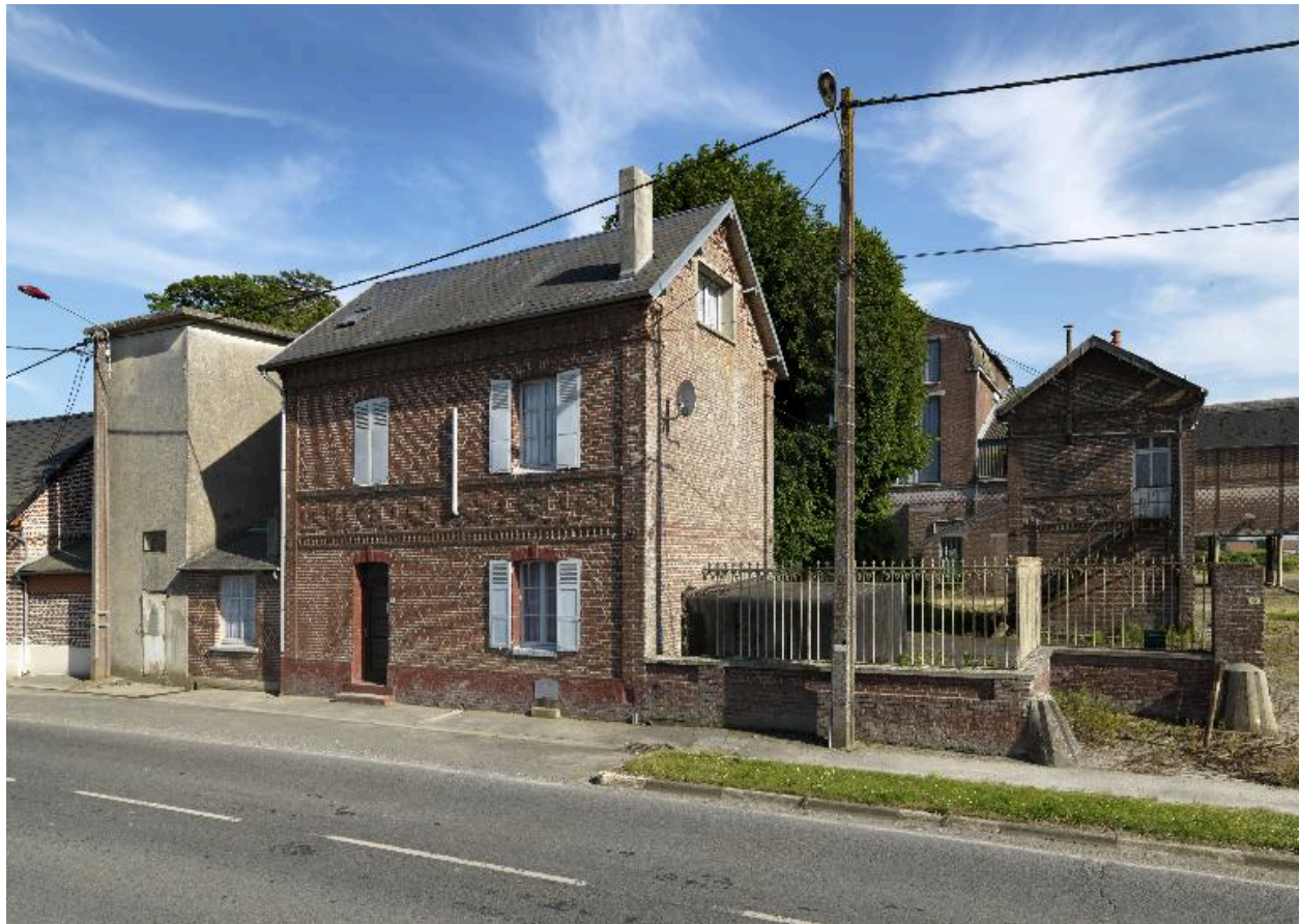
Logement de concierge et transformateur électrique de la râperie.
