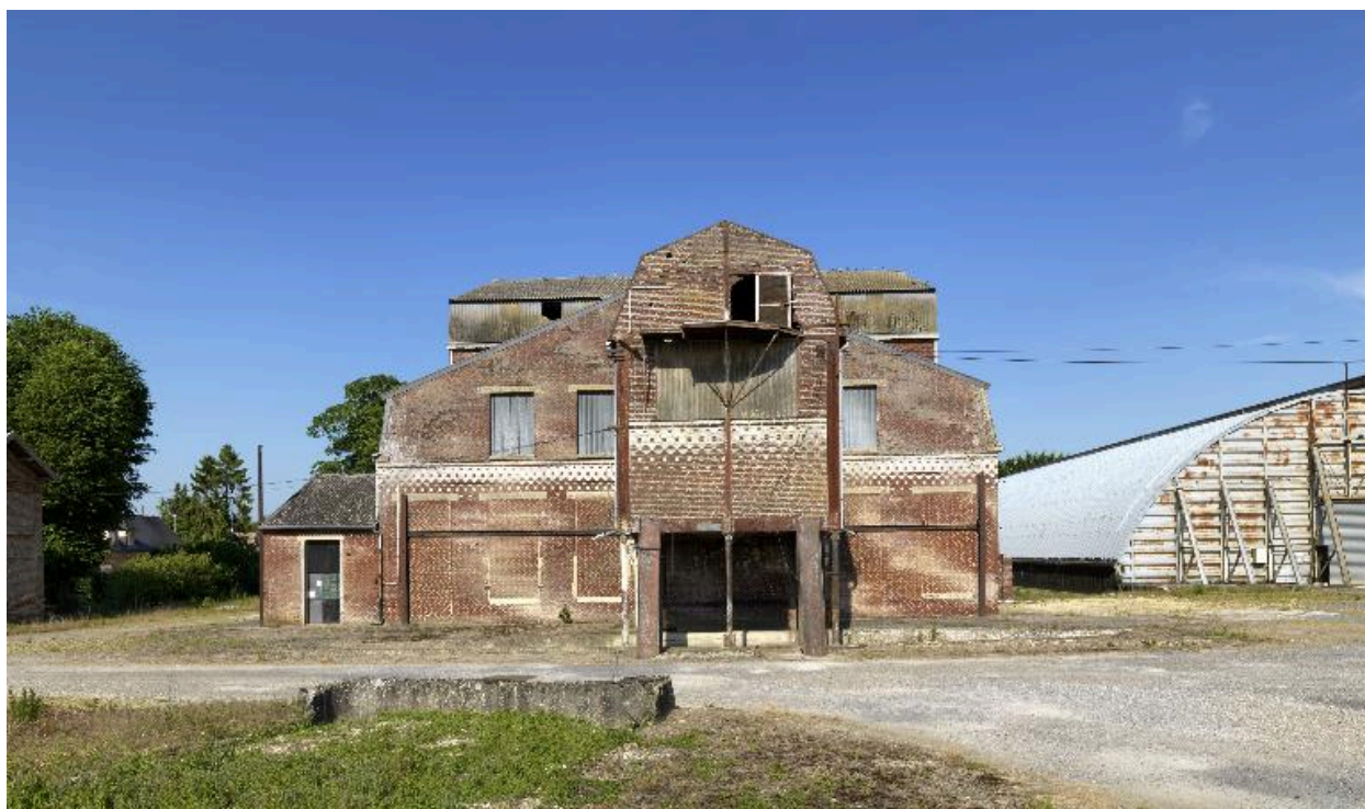
Atelier de fabrication de la râperie, vue de face.
