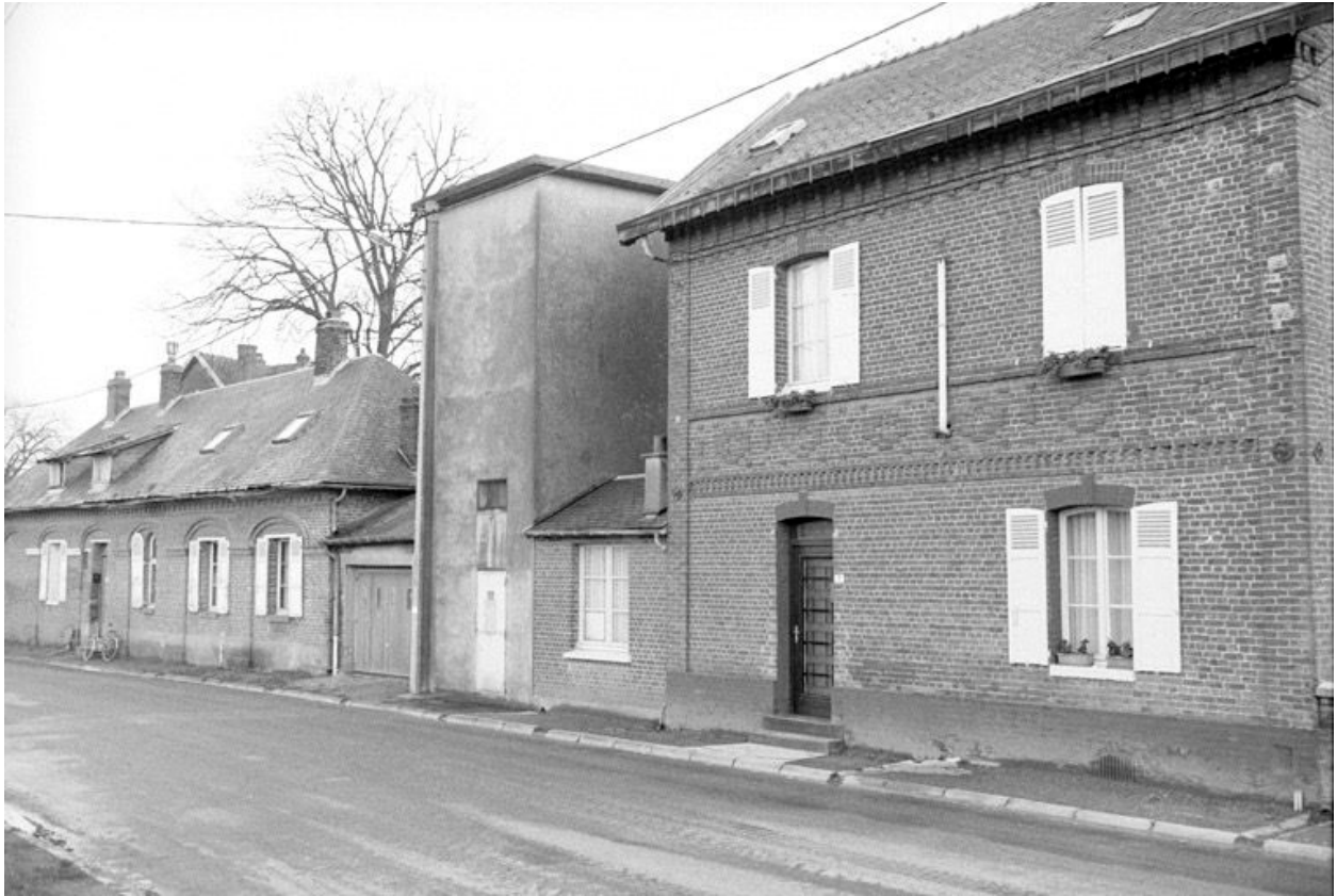
Conciergerie, transformateur, logement d'ouvriers, flanc nord.
