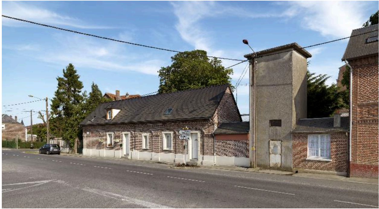
Transformateur électrique et logements d'ouvriers de la râperie.
