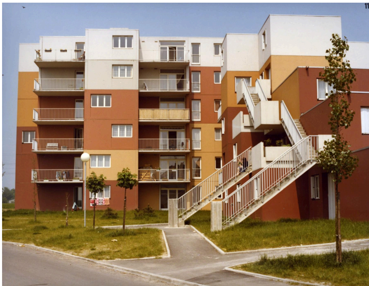
L'îlot 1 Les Fiacres en 1978 : habitat collectif (au fond) et intermédiaire (à droite) se combinent en une architecture à la modernité assumée (AC Villeneuve d'Ascq ; 16W3).
