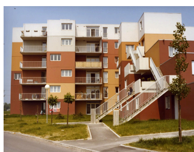
L'îlot 1 Les Fiacres en 1978 : habitat collectif (au fond) et intermédiaire (à droite) se combinent en une architecture à la modernité assumée (AC Villeneuve d'Ascq ; 16W3). Repro. Pierre Thibaut IVR32_20215900441NUCA
