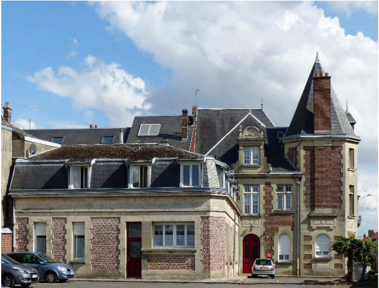
Vue des façades postérieures.
