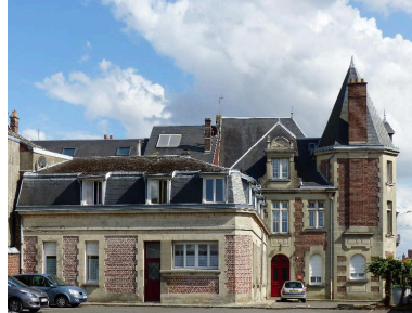
Vue des façades postérieures. Phot. Isabelle Barbedor IVR32_20178005279NUCA
