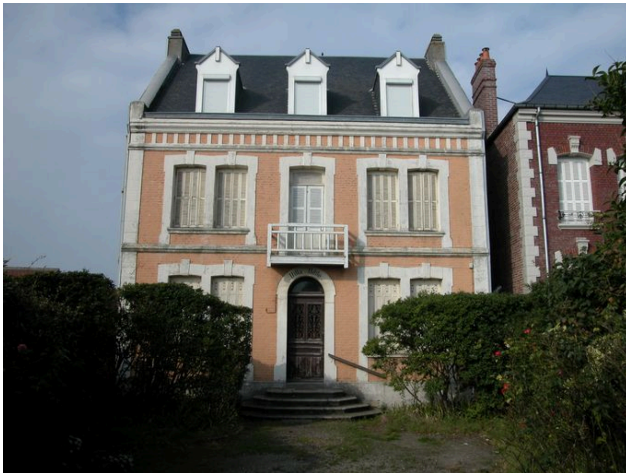
Vue d'ensemble de l'élévation antérieure.
