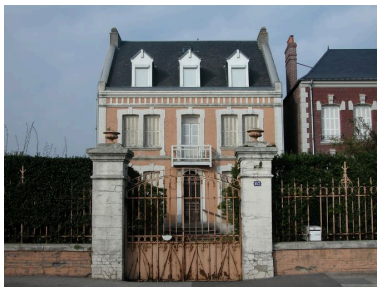
Vue d'ensemble de la maison et de sa clôture. Phot. Elisabeth Justome IVR22_20058003115NUCA
