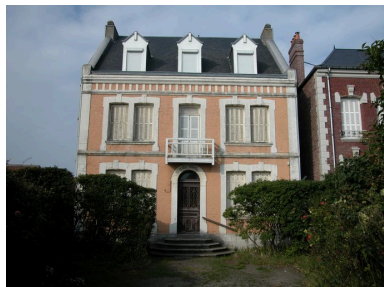
Vue d'ensemble de l'élévation antérieure. Phot. Elisabeth Justome IVR22_20058003114NUCA
