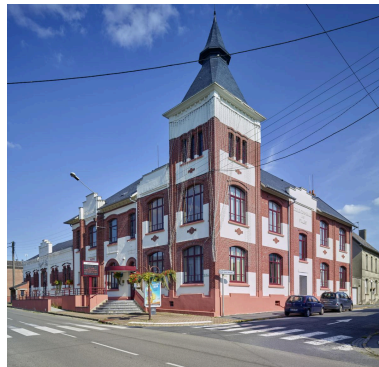
Vue d'ensemble de la mairie et de l'école de filles. Phot. Pierre Thibaut IVR22_20215900682NUCA
