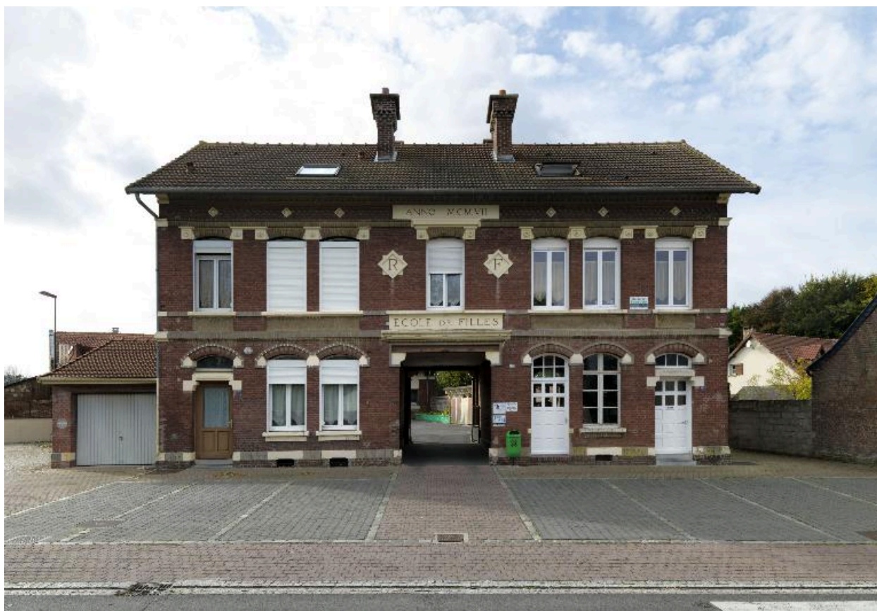
Vaudricourt - Ancienne "boutique" de serrurier.
