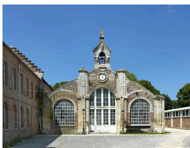
Friville-Escarbotin - Usine de serrurerie Maquennehem et Imbert, puis Imbert Ricquier, puis Bricard. Phot. Thierry Lefébure IVR22_20148000418NUC2A
