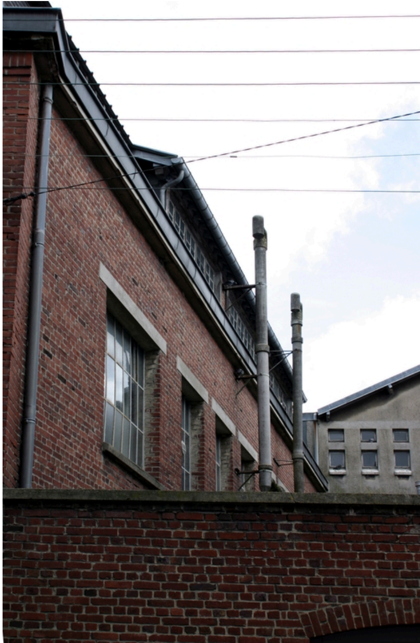
L'extension des anciens magasins rue de Mulhouse et Cité de Mulhouse construite dans l'entre-deux-guerres : façade postérieure, rue de Colmar.
