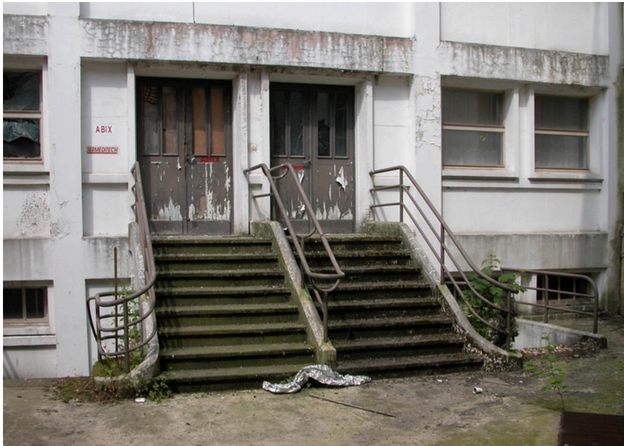
Escaliers dans la cour de l'usine.
