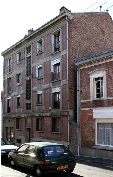
Façade antérieure de l'immeuble d'habitation, rue de Colmar. Phot. Frédéric Pillet IVR22_20040201193NUCA
