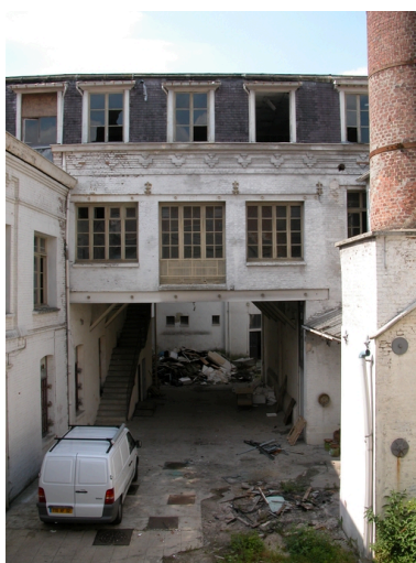
Anciens ateliers de préparation, piquage, broderie, et magasin à guipure : façade est.
