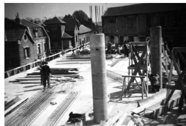
Chantier de construction des ateliers, 1948 (IFA). Phot. Pillet Frédéric IVR22_20040201142NUCAB
