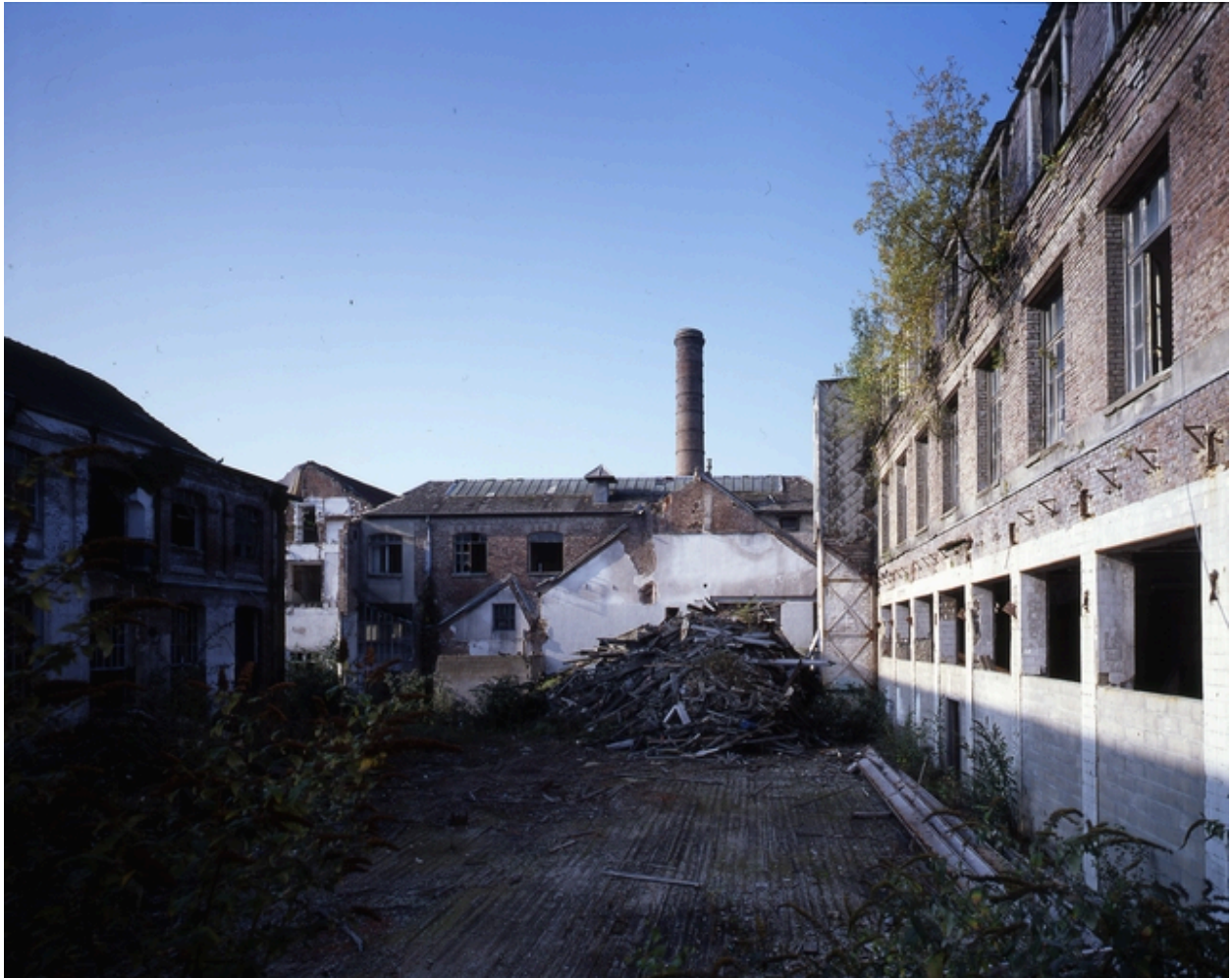
Vue des bâtiments en cours de démolition.
