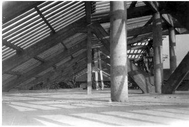
Charpente des ateliers construits en 1948 (IFA). Phot. Pillet Frédéric IVR22_20040201147NUCAB
