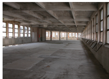
Ateliers des années 1946-48. Phot. Frédéric Pillet IVR22_20040200774NUCA
