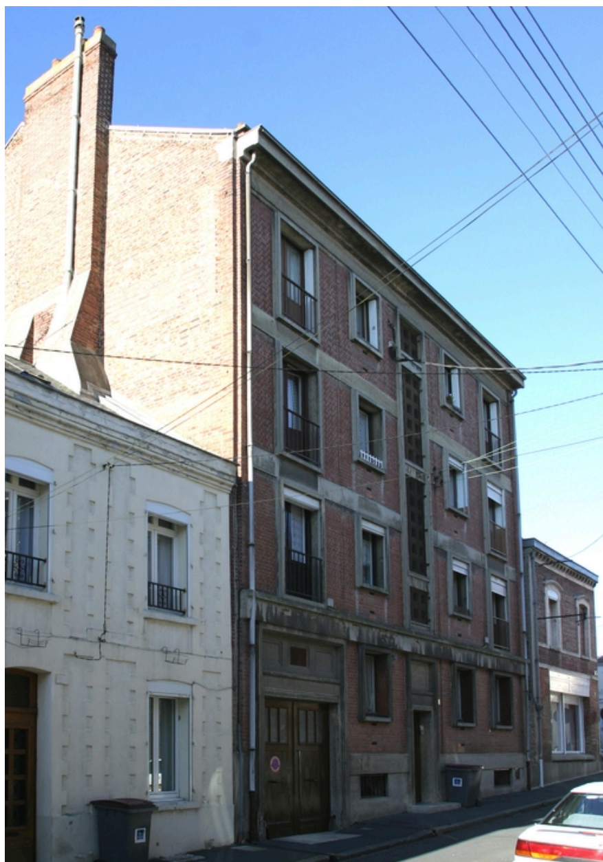
Façade antérieure de l'immeuble d'habitation, rue de Colmar.
