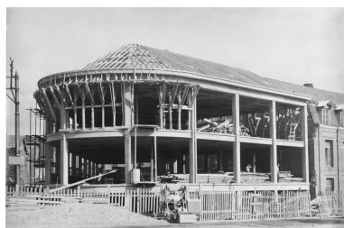
Chantier de construction des ateliers, par Desprey-Pollet, vers 1948 (IFA). Phot. Pillet Frédéric IVR22_20040201144NUCAB
