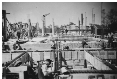
Chantier de construction des ateliers, 1948 (IFA). Phot. Pillet Frédéric IVR22_20040201141NUCAB
