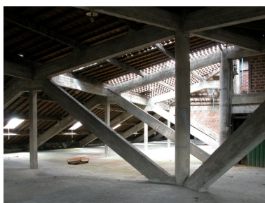
Ateliers des années 1946-48 : charpente en béton armé. Phot. Frédéric Pillet IVR22_20040200776NUCA
