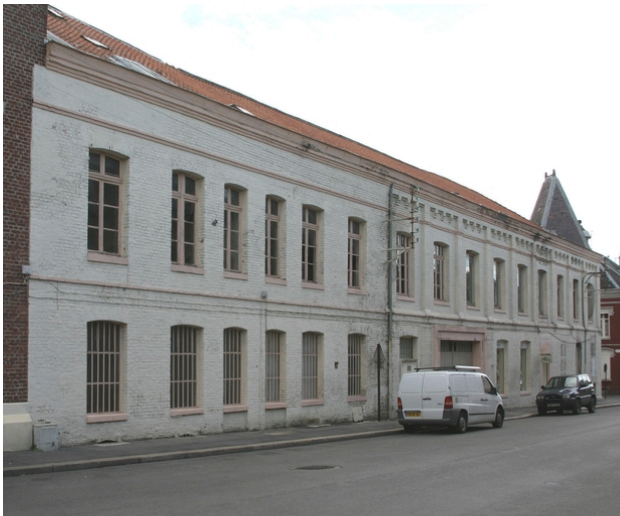
Façade antérieure des bâtiments construits en 1887, rue de Mulhouse.
