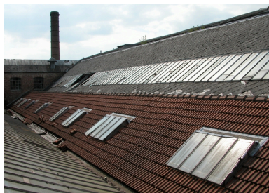
Toitures des ateliers de fabrication de la guipure reconstruits.
