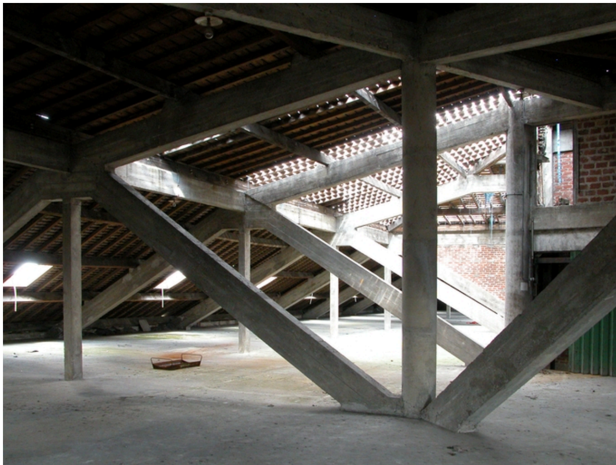
Ateliers des années 1946-48 : charpente en béton armé.
