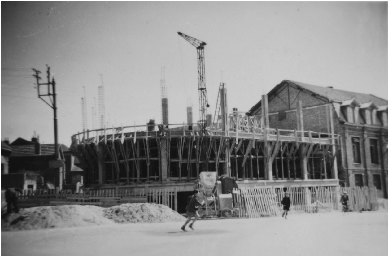
Chantier de construction des ateliers, 1948 (IFA).
