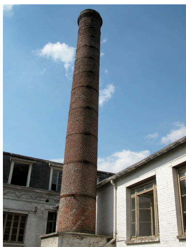
La cheminée d'usine. Phot. Frédéric Pillet IVR22_20040200784NUCA
