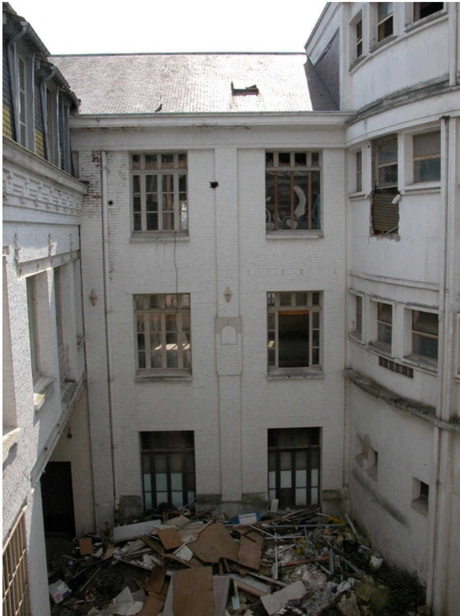
Cour intérieure de l'usine (au fond, l'atelier de raccomodage, de ponçage et le magasin à guipure reconstruit en 1919).
