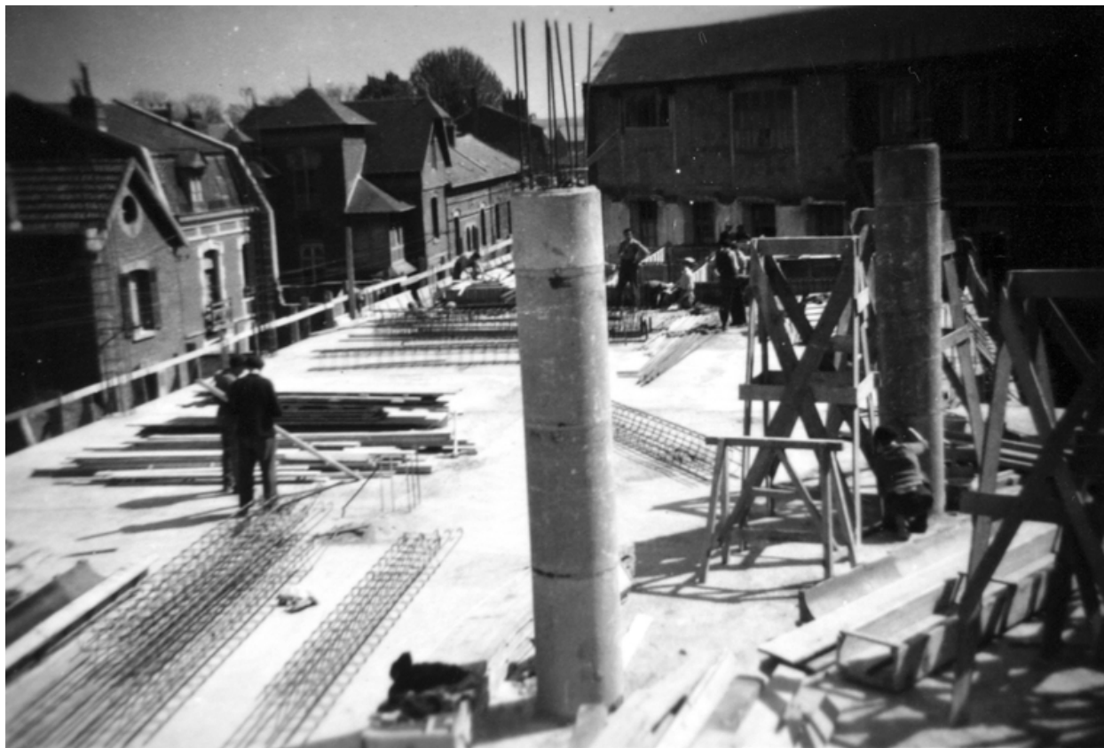
Chantier de construction des ateliers, 1948 (IFA).
