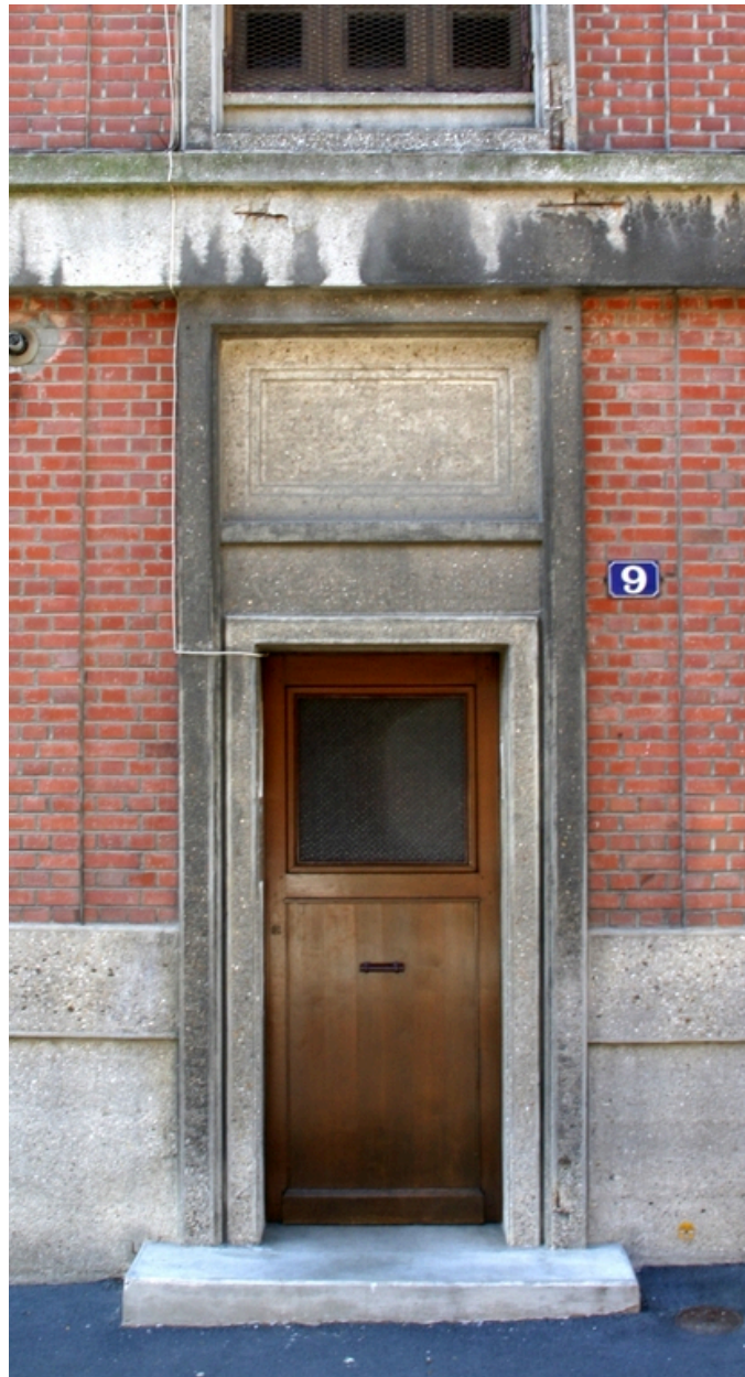
Entrée de l'immeuble d'habitation, rue de Colmar.
