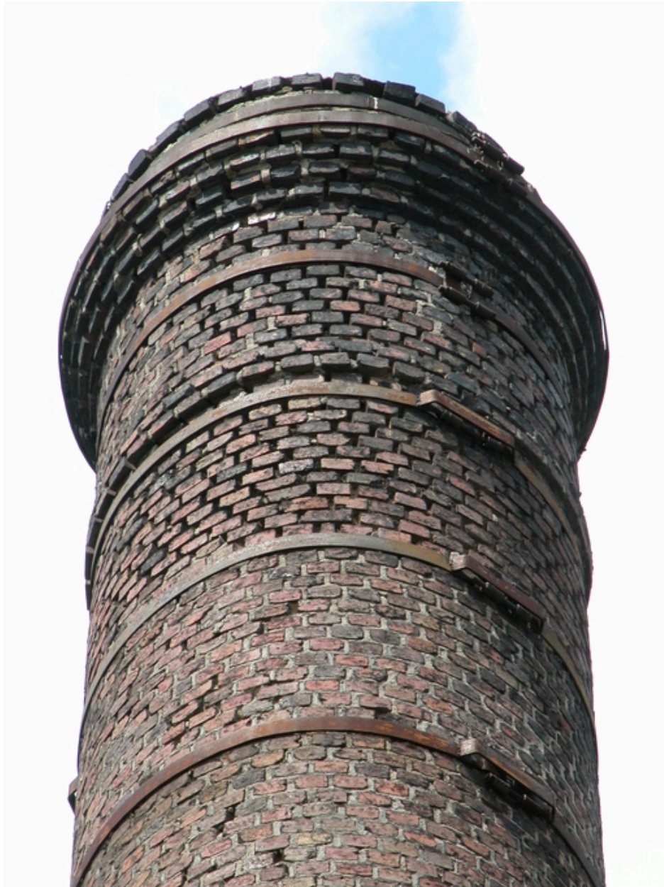
Sommet de la cheminée d'usine.
