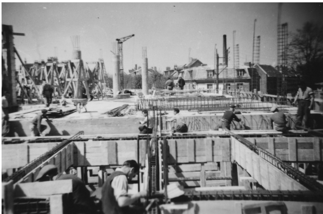
Chantier de construction des ateliers, 1948 (IFA).
