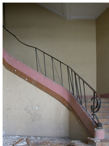
Escaliers des ateliers des années 1946-48.
