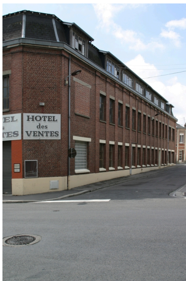
L'extension des anciens magasins rue de Mulhouse et Cité de Mulhouse construite dans l'entre-deux-guerres : façade antérieure, Cité de Mulhouse. Phot. Frédéric Pillet IVR22_20040200788NUCA
