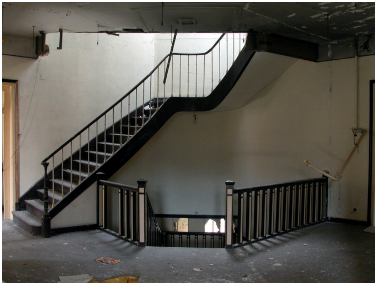
Escalier implanté à l'angle des rues de Mulhouse et Richard-Lenoir (premier étage).
