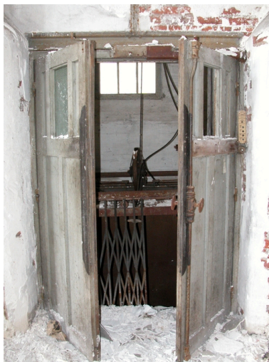
Vestiges du monte-charge des ateliers de fabrication de guipure.
