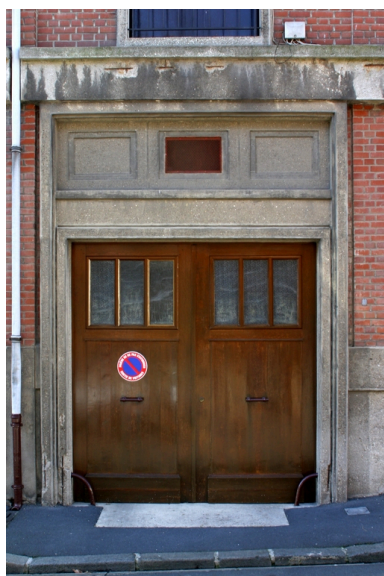
Porte cochère de l'immeuble d'habitation, rue de Colmar. Phot. Frédéric Pillet IVR22_20040201195NUCA
