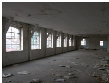
Premier étage de l'atelier de guipure construit en 1887, destiné au stockage des piqués et des échantillons dans les années 1920. Phot. Frédéric Pillet IVR22_20040200755NUCA
