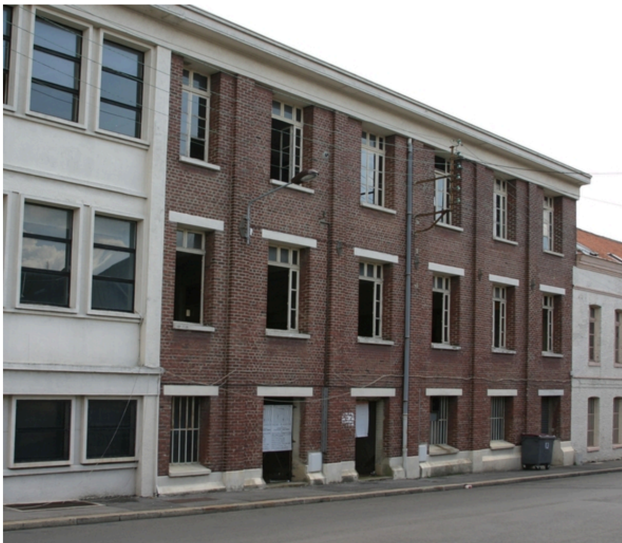
Ancien atelier de ponçage et raccommodage des guipures, reconstruit en 1919.
