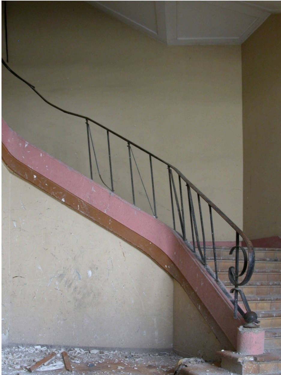
Escaliers des ateliers des années 1946-48.
