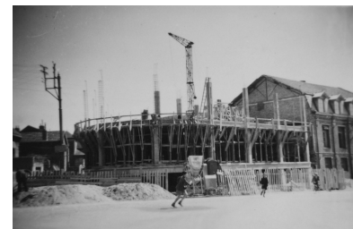
Chantier de construction des ateliers, 1948 (IFA). Phot. Pillet Frédéric IVR22_20040201143NUCAB
