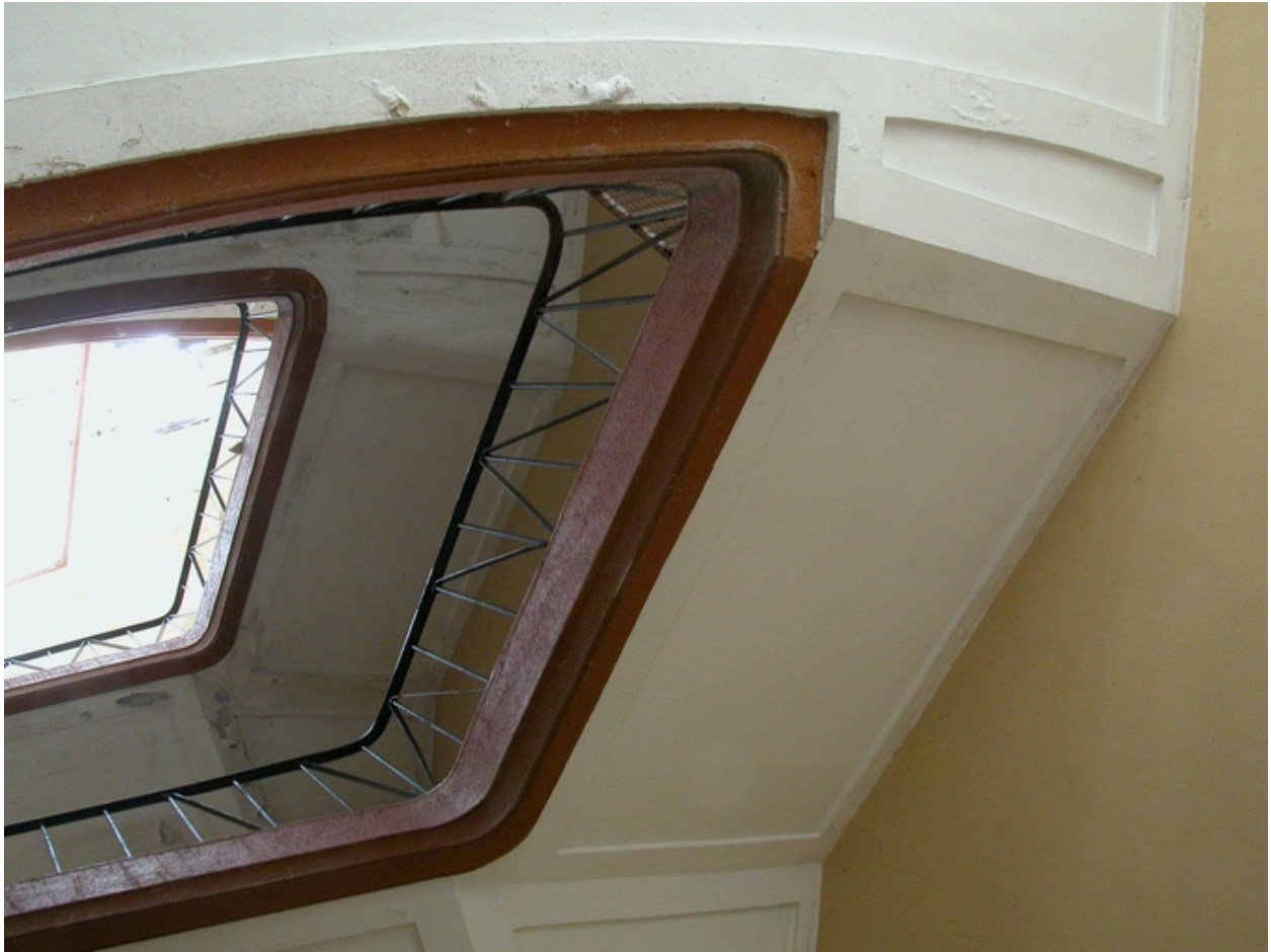
Escaliers des ateliers des années 1946-48.
