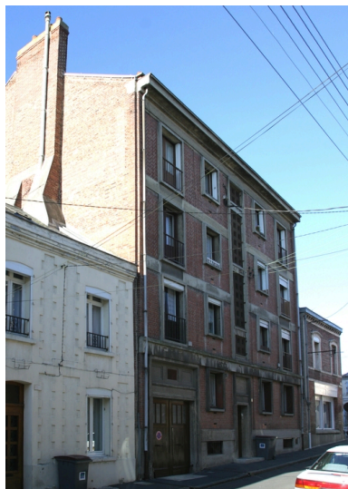
Façade antérieure de l'immeuble d'habitation, rue de Colmar. Phot. Frédéric Pillet IVR22_20040201192NUCA
