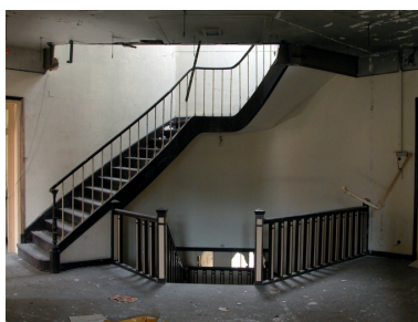
Escalier implanté à l'angle des rues de Mulhouse et Richard-Lenoir (premier étage). Phot. Frédéric Pillet IVR22_20040200746NUCA
