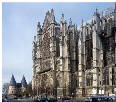
Vue du flanc sud de la cathédrale, avec les deux tours du palais épiscopal. Phot. Thierry Lefébure IVR22_19996001584VA
