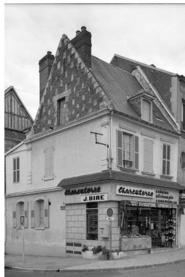
Élévation antérieure. Phot. Fabrice Charrondière IVR22_19856001365X
