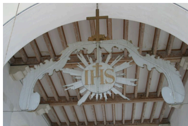
Vue antérieure de la poutre de gloire. Phot. Inès Guérin IVR22_20030202712NUCA
