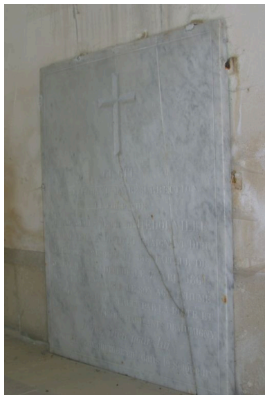
Vue de la dalle funéraire fixée au mur sud. Phot. Irwin Leullier IVR22_20050200945NUCA
