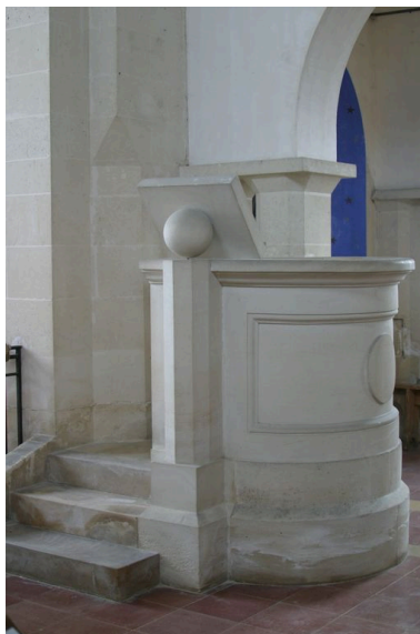
Vue de la chaire à prêcher. Phot. Inès Guérin IVR22_20030202714NUCA
