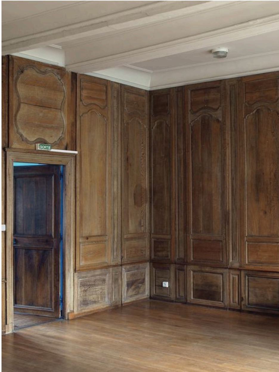
Vue générale d'un angle, vers la porte d'entrée
