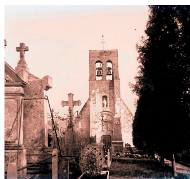
L'église de Pont-de-Metz et son cimetière, photographie, Codevelle, 1930 (Archives communales et communautaires d'Amiens métropole ; 12Z56). IVR32_20188005045P
