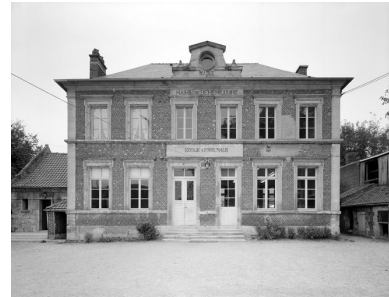
Vue générale. Phot. Jean-Michel Perrin IVR22_19846001225V
