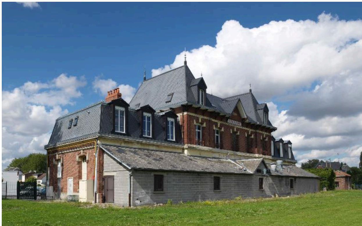
Vue des façades postérieures.
