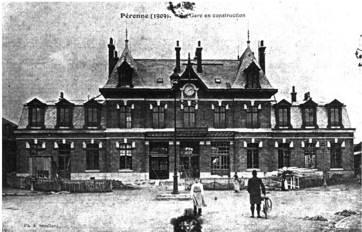
La gare en construction, vers 1909 (Musée Danicourt, Péronne).
