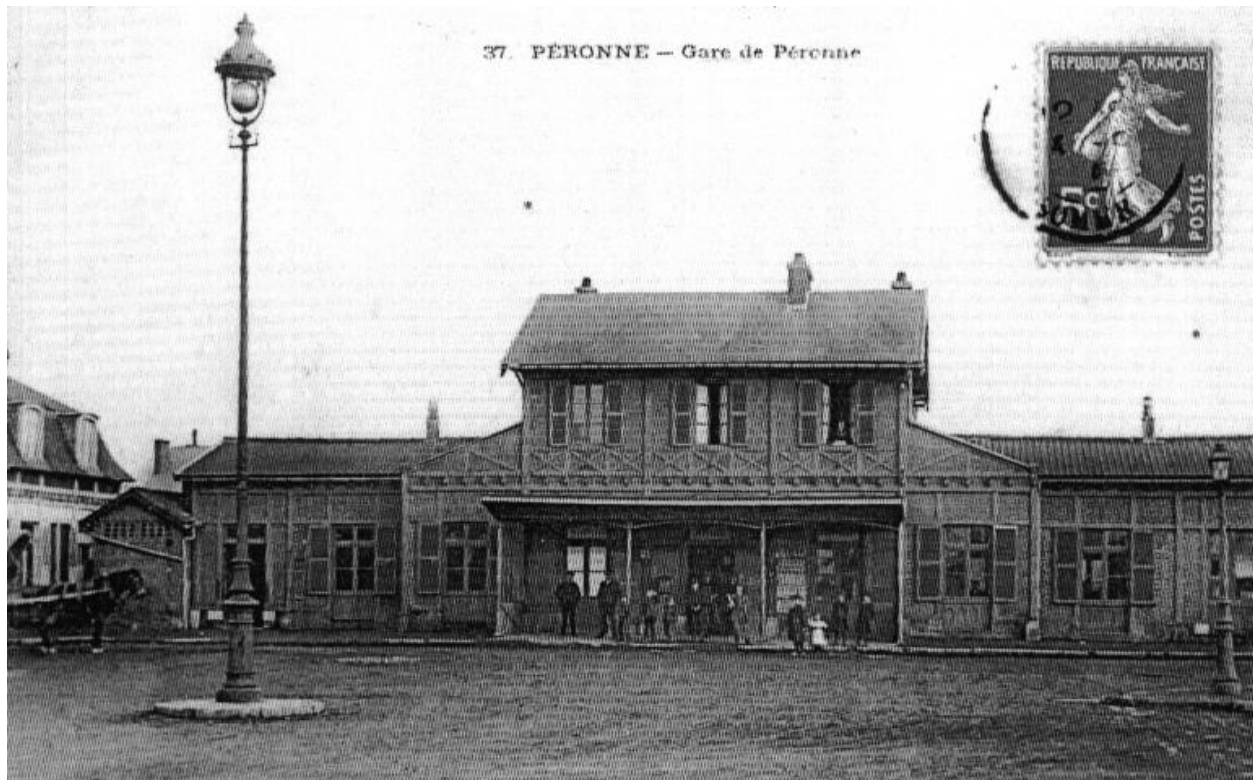
La gare, avant 1909 (AD Somme ; 8 Fi 3310).
