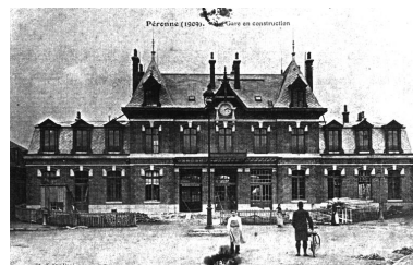
La gare en construction, vers 1909 (Musée Danicourt, Péronne). Phot. Gilles-Henri Bailly (reproduction) IVR22_20158005546NUCA
