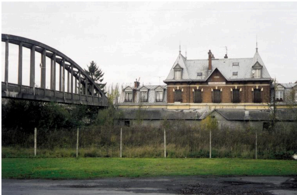
Vue d'ensemble de la gare avec la passerelle.
