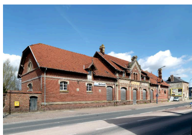
Vue d'ensemble sur rue. Phot. Thierry Lefébure IVR22_20138000078NUC2A
