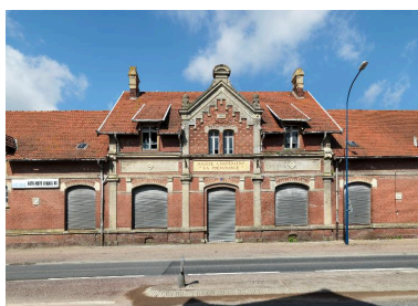
Façade sur rue, vue de face. Phot. Thierry Lefébure IVR22_20138000079NUC2A
