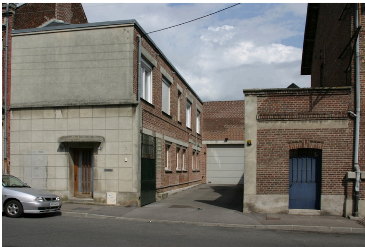
Entrée des ateliers.
