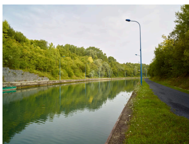
Vue depuis la tête nord vers le canal et le quai de stationnement des péniches. Phot. Pierre Thibaut IVR32_20216200677NUCA
