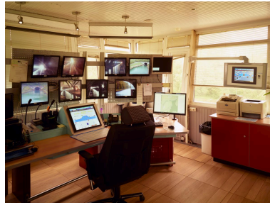
Tête nord : intérieur du poste de commande, passerelle de contrôle. Phot. Pierre Thibaut IVR32_20216200768NUCA
