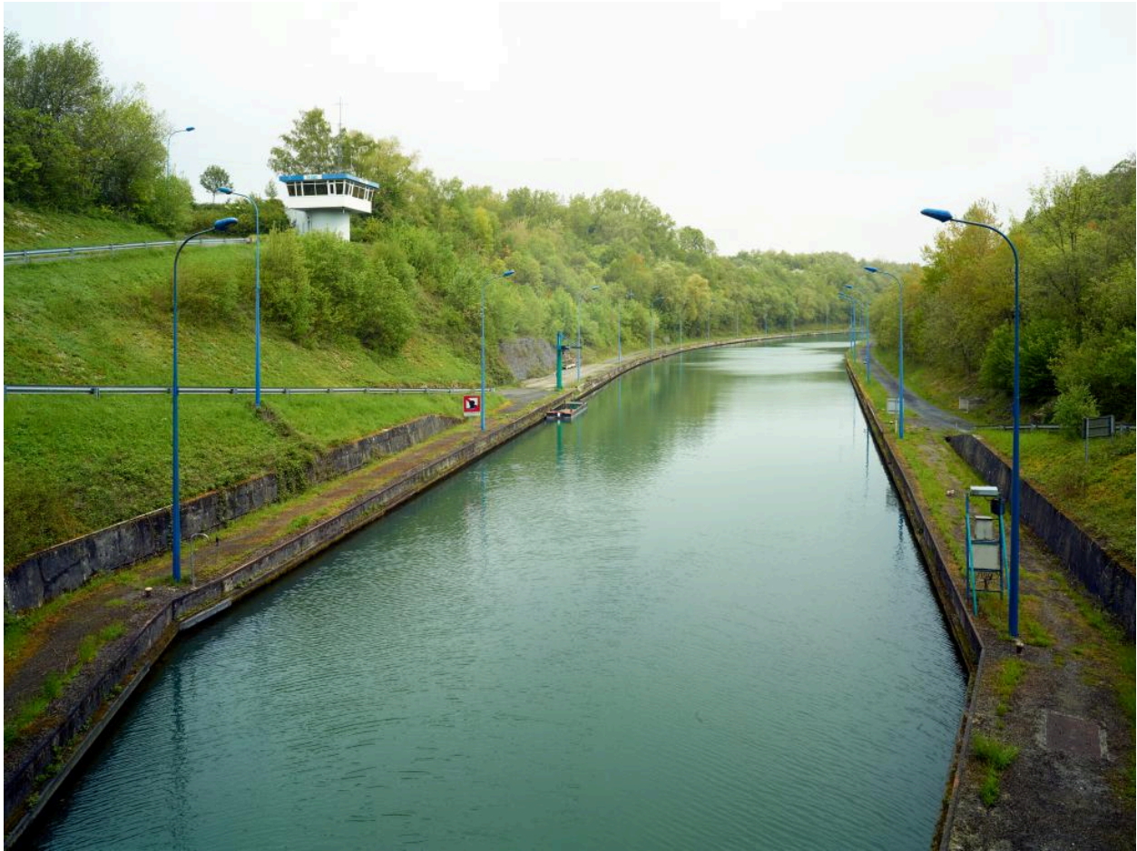
Vue depuis la tête nord du tunnel vers le canal, quai de stationnement des péniches et poste de commande.
