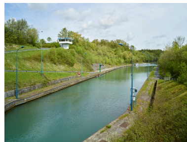
Tête nord, poste de commande et quai de stationnement de péniches. Phot. Pierre Thibaut IVR32_20216200667NUCA
