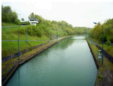
Vue depuis la tête nord du tunnel vers le canal, quai de stationnement des péniches et poste de commande. Phot. Pierre Thibaut IVR32_20216200771NUCA
