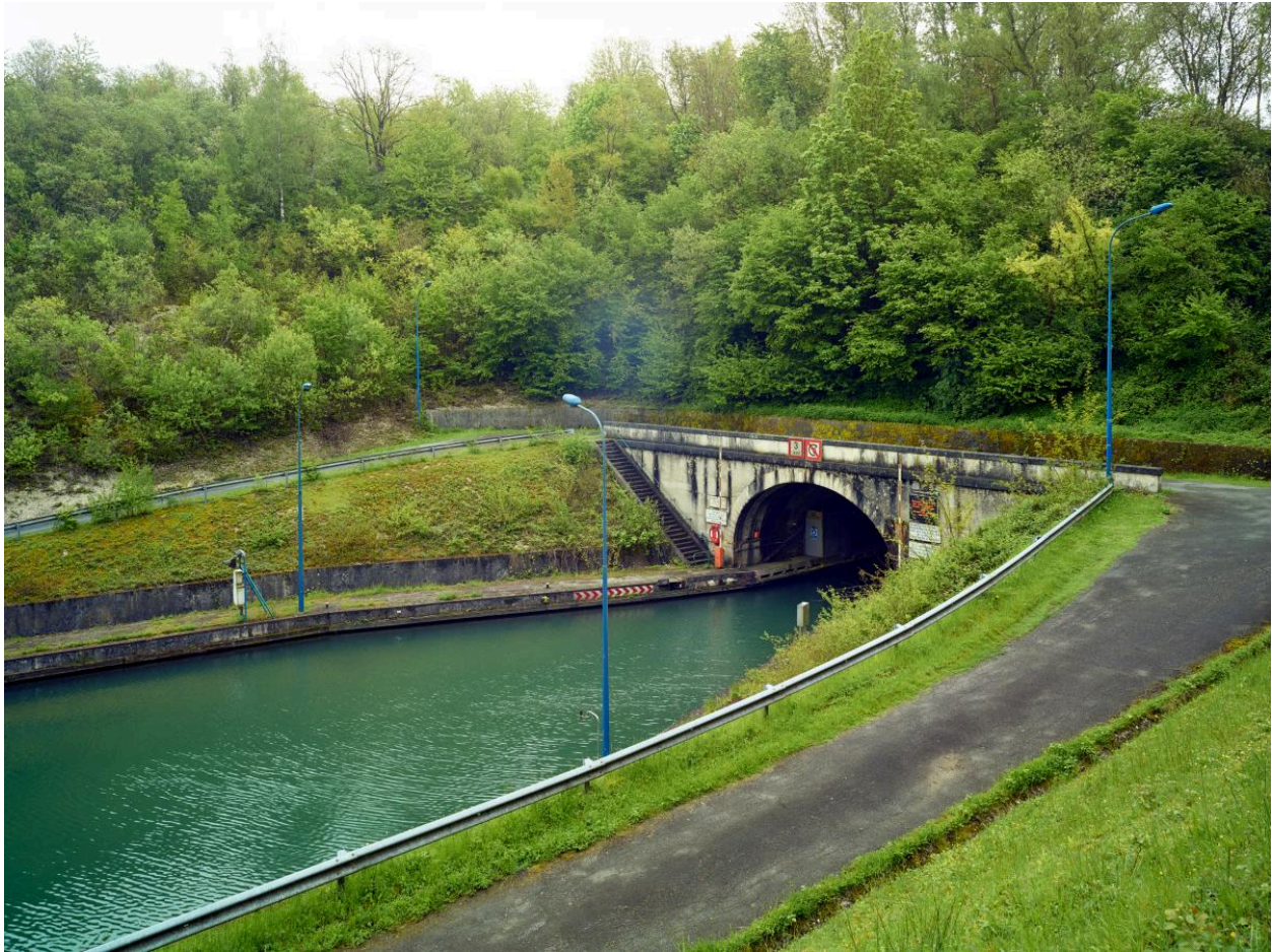
Tête nord et voie de circulation.
