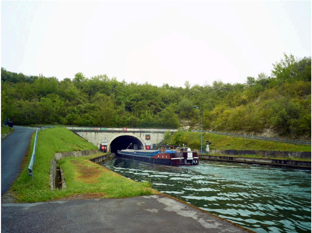
Tête nord, voie de circulation et quai de stationnement pour les péniches.
