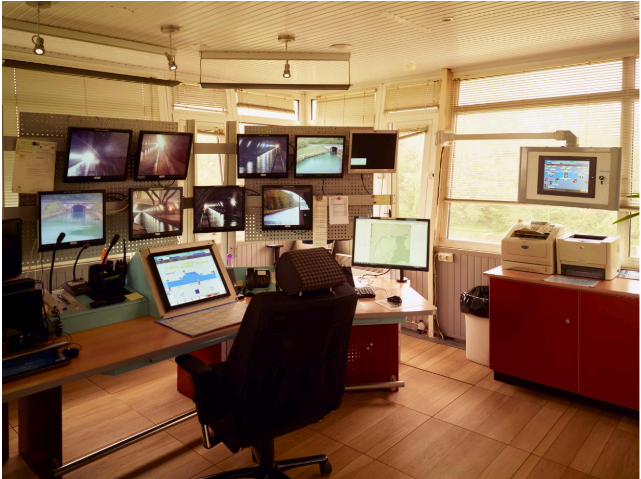
Tête nord : intérieur du poste de commande, passerelle de contrôle.
