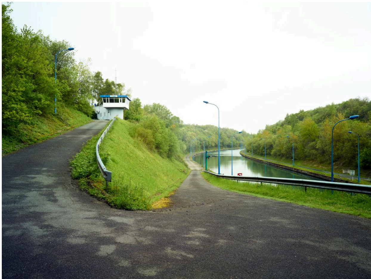
Vue depuis la tête nord. Poste de commande, canal et voie de circulation.
