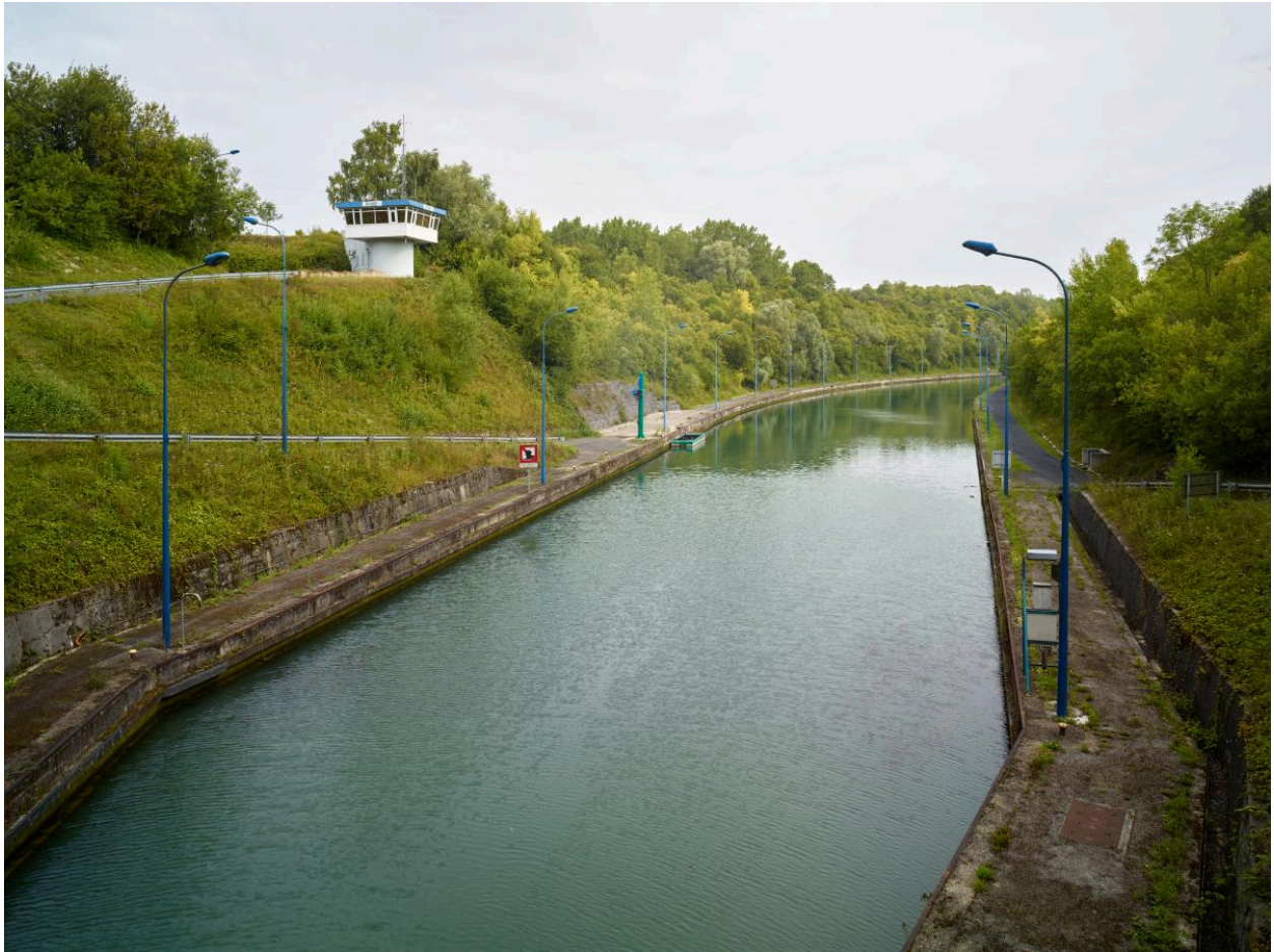
Vue depuis la tête nord. Poste de commande et quai de stationnement des péniches.
