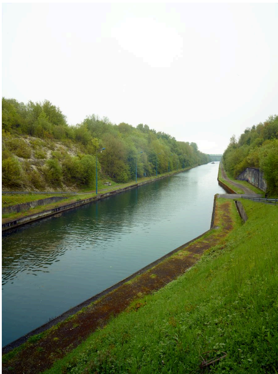
Vue depuis la tête nord vers le canal et le quai de stationnement des péniches.
