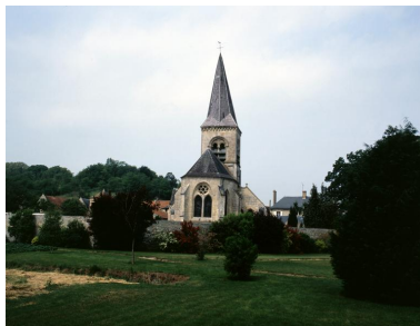
Vue du chevet. Phot. Irwin Leullier IVR22_20050201683XA
