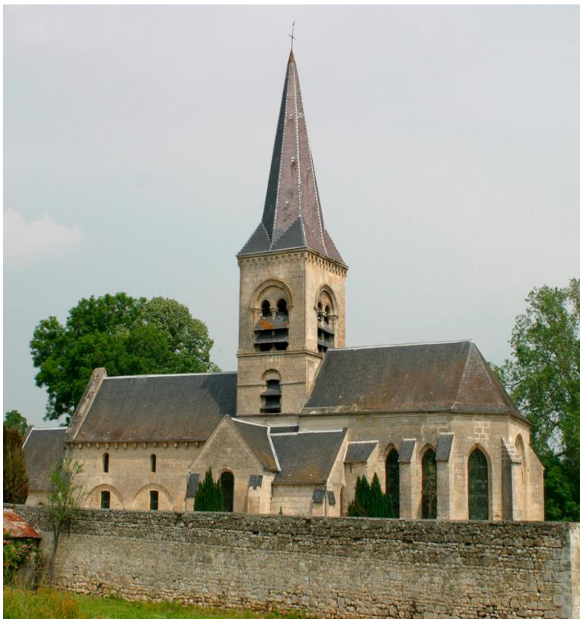
Vue de l'élévation sud.
