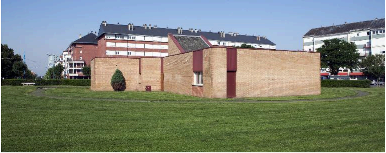
Élévation latérale gauche et façade postérieure.
