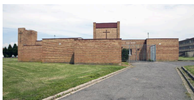
Élévation antérieure de l'église. Phot. Pierre Thibaut IVR31_20155900256NUCA
