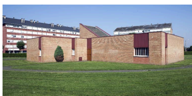
Élévation latérale gauche. Phot. Pierre Thibaut IVR31_20155900253NUCA
